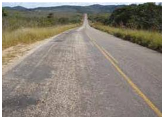
Figura 9 – Desgaste superficial
