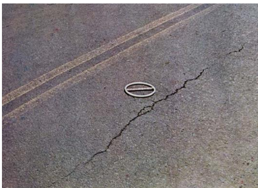
Figura 3 – Trinca longitudinal
