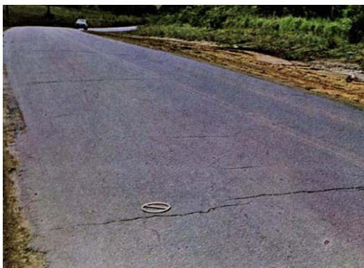
Figura 2 – Trinca transversal
