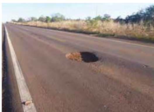
Figura 10 – Panela ou buraco
