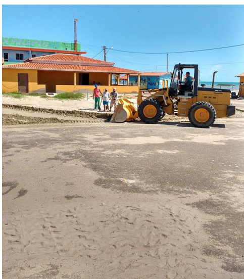
Figura 4.b. Retirada da areia próximo dos imóveis na Praia de Tremembé. Fonte: Autoria própria.
