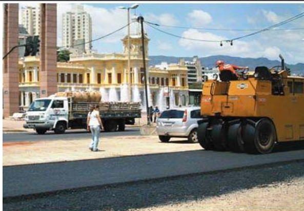
Figura 2. Obra de pavimentação em asfalto-borracha. Fonte:
