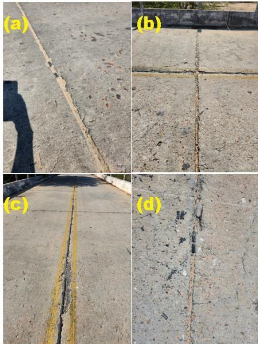
Figura 15 - Juntas de dilatação sujas e ressecadas
