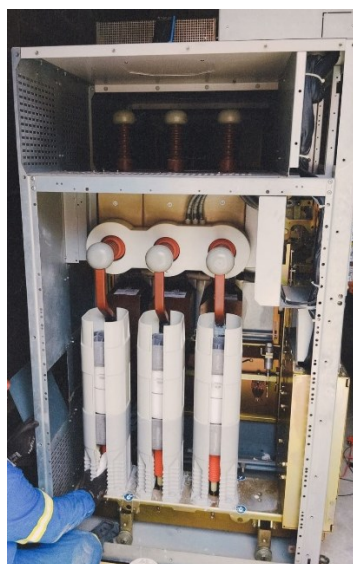
FIGURA 8. Painel SIMOSEC de entrada aberto para manutenção corretiva. [Autoria própria]
