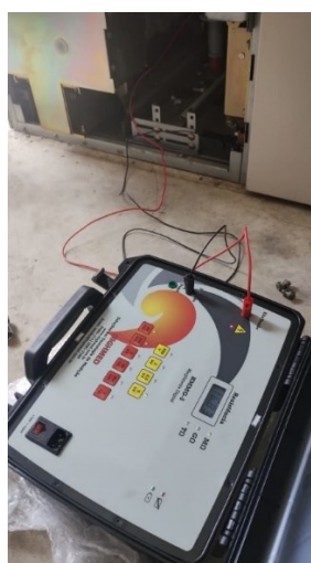
FIGURA 12. Operação de megômetro 5kV Highmed para novos testes de isolamento elétrica após manutenção corretiva; [Autoria própria]
