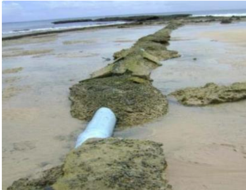
Figura 31: Sistema de captura de água do mar em Fernando de Noronha.
