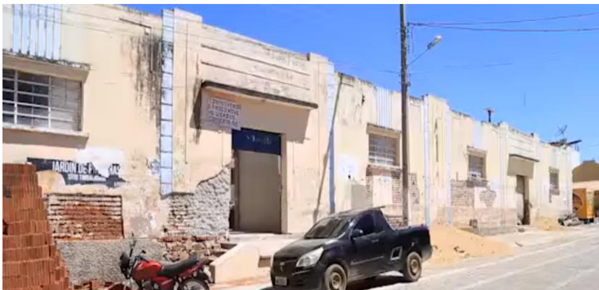
Figura 4 - Vista lateral da edificação
