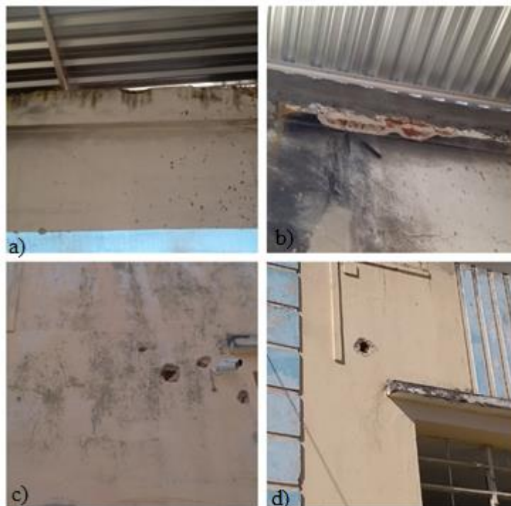
Figura 9 - Alguns dos locais de extração das amostras: a) Fachada interna lateral esquerda; b) Fachada interna lateral direita; c) Fachada externa posterior; d) Fachada externa lateral esquerda.
