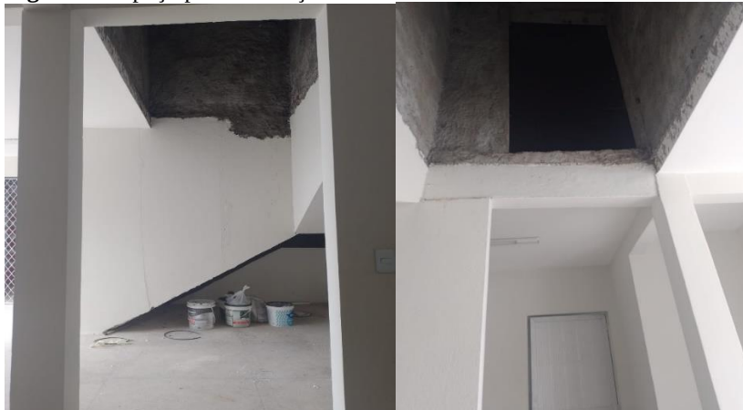
Figura 5: Espaço para instalação do elevador ao lado da escadaria.
