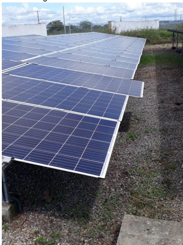
Figura 34 – Painéis deslocados.
