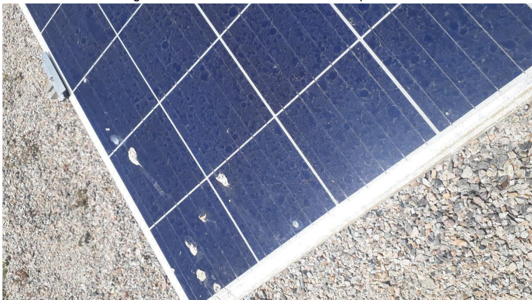
Figura 46 – Módulo com excremento de pássaros.
