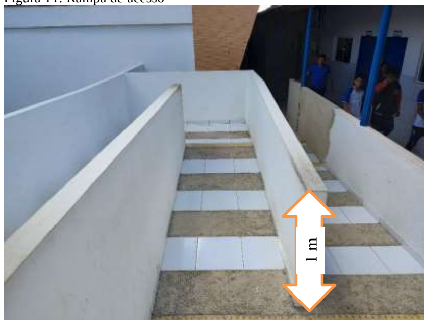
Figura 11: Rampa de acesso
