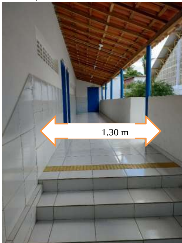
Figura 3: Corredor externo que dá acesso a rampa do lado direito, e aos 3 banheiros para os alunos, masculino, feminino e acessível.
