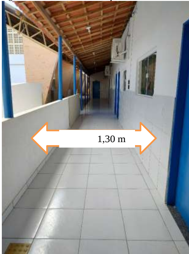
Figura 2: Corredor de acesso a quadra e todas as salas de aulas externas
