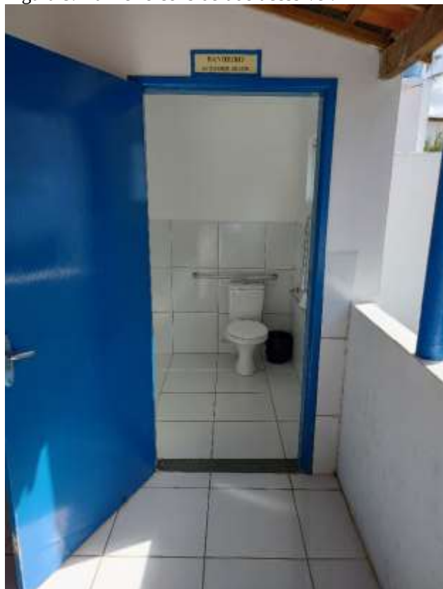
Figura 8: Banheiro considerado acessível.
