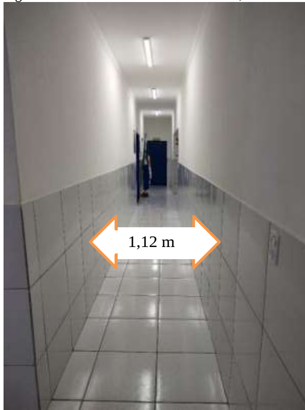
Figura 4: Corredor de acesso ao refeitório, e no fundo as salas da direção e professores
