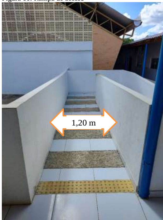
Figura 10: Rampa de acesso
