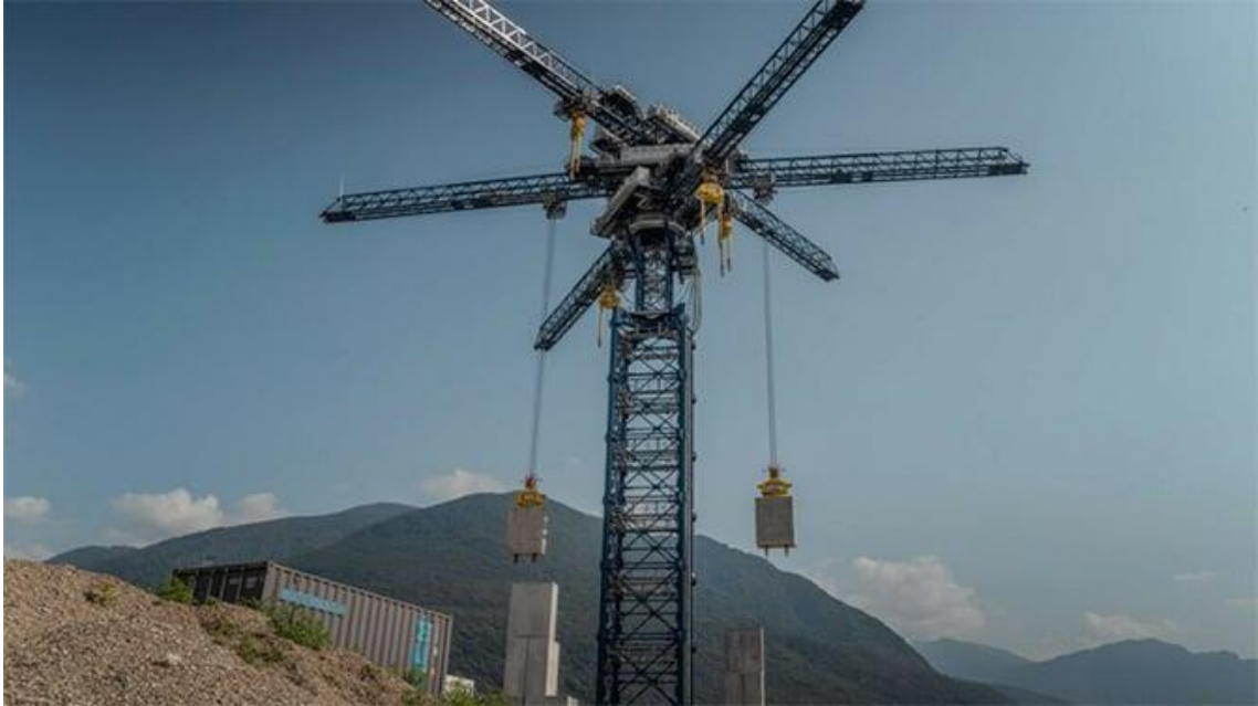
Figura 9 - Ilustração do sistema de armazenamento de energia da Energy Vault
