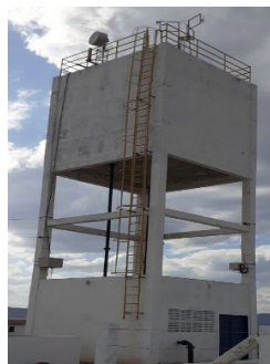
Figura 12: Caixa d'água de Nova barra de Santana.
