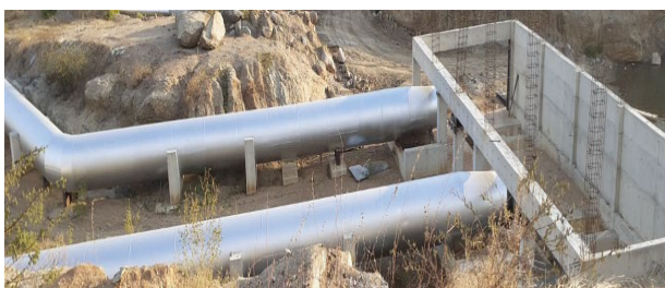
Figura 4: As tubulações que irão levar as águas da transposição para o reservatório de tratamento.
