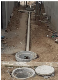
Figura 11: Construção da estação elevatória de esgotos do distrito de Nova barra de Santana.
