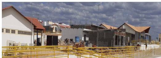
Figura 10: Construção de prédios comerciais de Nova barra de Santana, dos proprietários indenizados.
