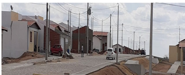
Figura 8: Casas do distrito de Nova barra de Santana, ainda em processo de construção.
