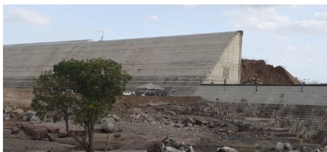
Figura 1: Barragem de Oiticica em construção
