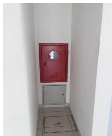
Figura 14- Hidrante (Autoria própria).
