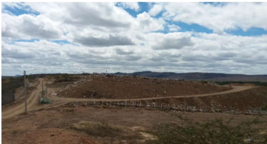
Figura 28 - Vista panorâmica da extensão do aterro sanitário, Sousa-PB.
