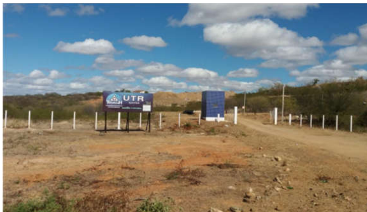
Figura 26 – Entrada principal do aterro sanitário da cidade de Sousa – PB.
