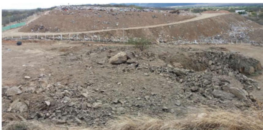
Figura 27 - Vista panorâmica do aterramento do aterro sanitário, Sousa-PB.
