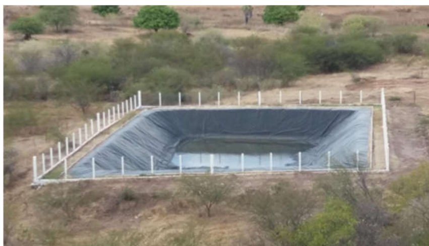
Figura 29 - Lagoa de estabilização do aterro sanitário, Sousa-PB.
