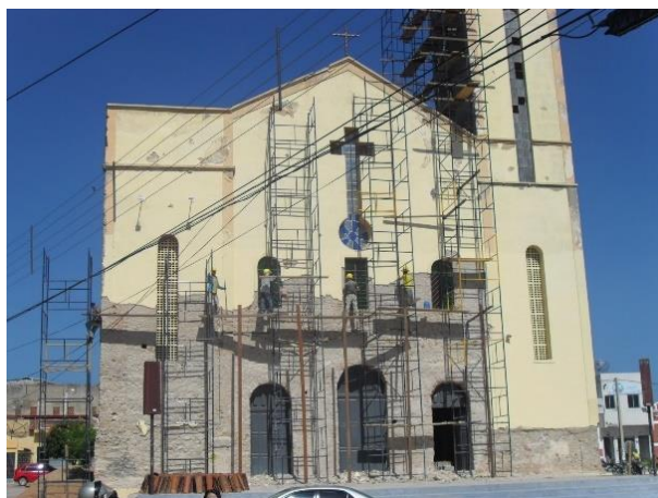
Figura 31 - Reformas realizadas na Igreja da Matriz de Nossa Senhora da Conceição - ano de 2012.
