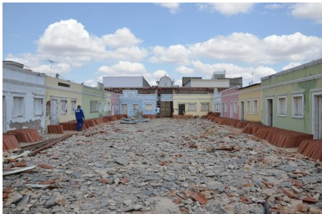
Figura 36 - Obras no interior do Mercado Público - ano de 2017.
