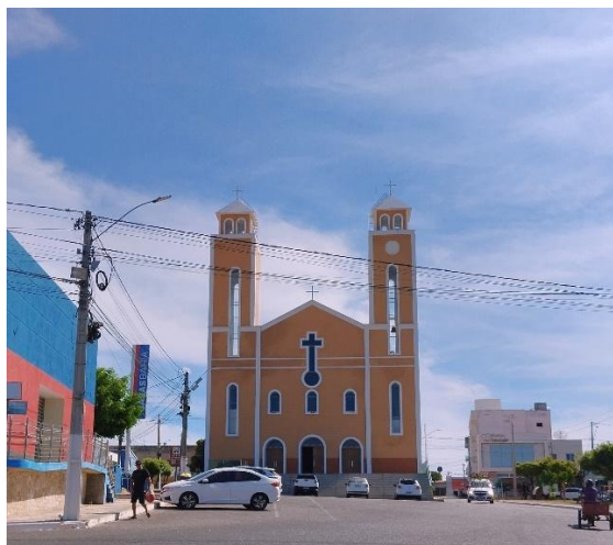
Figura 32 - Fachada da Igreja da Matriz – atualmente (2025).
