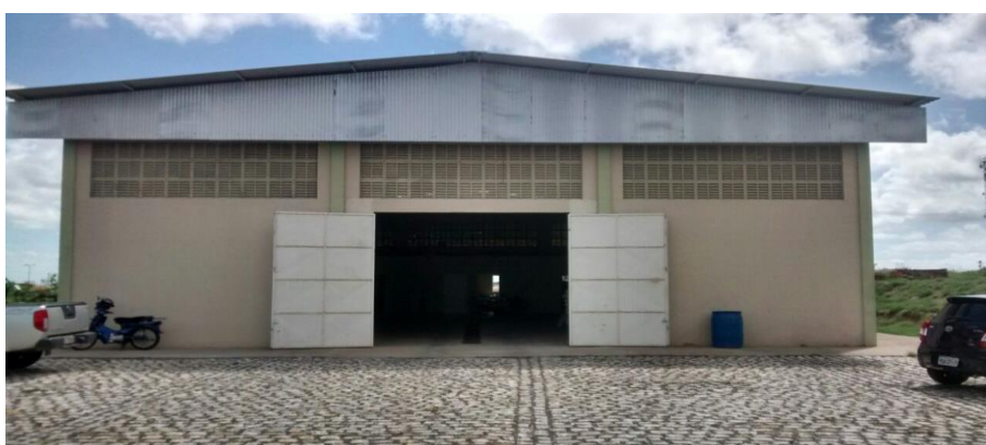
Figura 7. Galpão da fábrica de ração. Fonte: Autor
