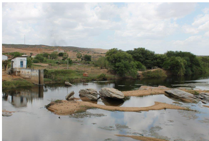
Figura 5 - Base de captação do SAAE Jaguaribe.
