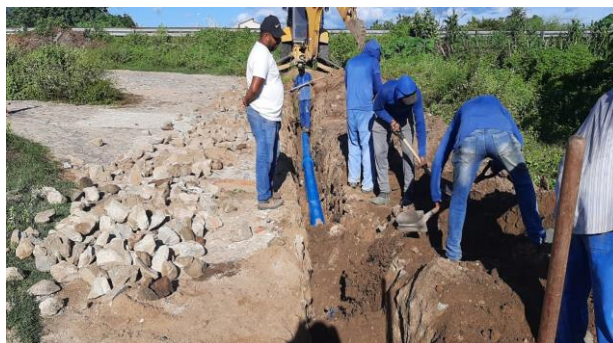
Figura 20 - Troca de tubulação para ampliação do sistema de abastecimento.
