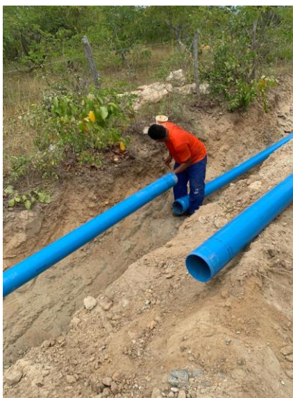
Figura 22 - Adutora em fase de execução.
