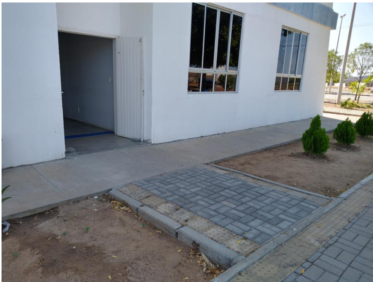
Figura 10: Saída de emergência do prédio Administrativo.
