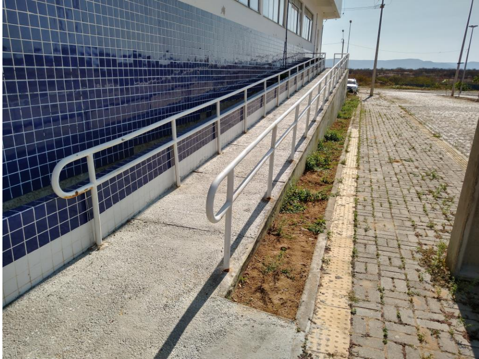
Figura 29: Rampa à direita com deslocamento à 90° - Prédio de Salas de Professores I.
