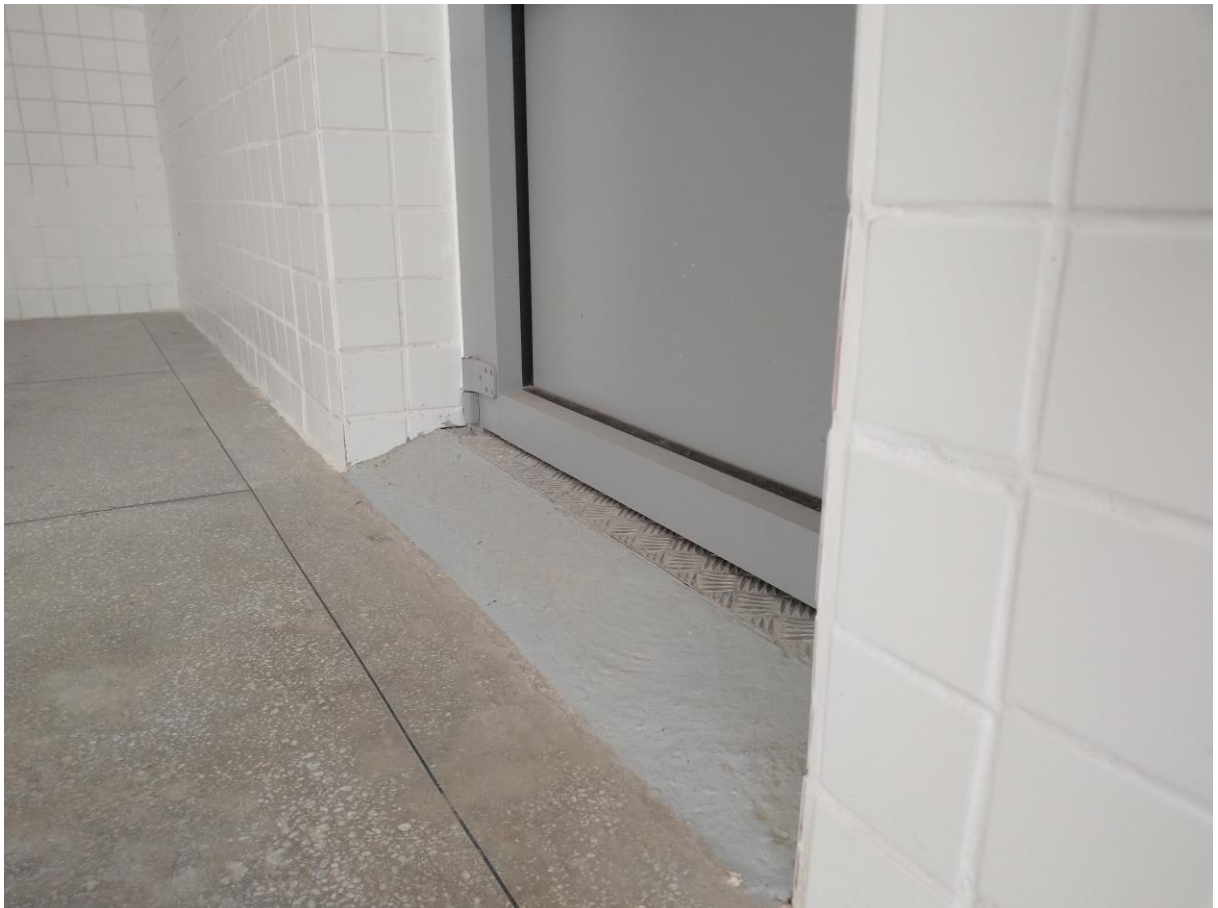
Figura 20: Rampa no patamar de elevação no prédio de Laboratório de Tecnologia da Informação.
