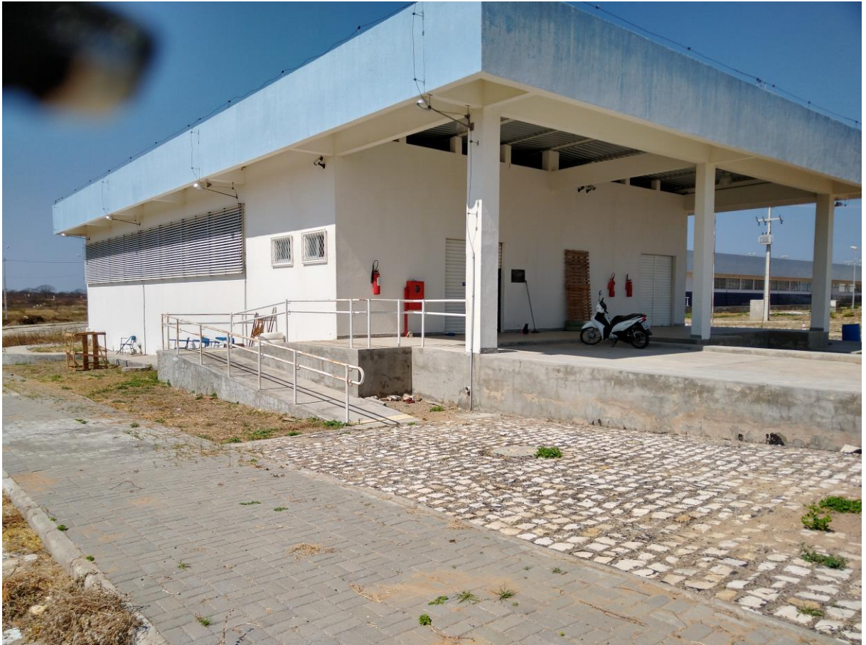
Figura 39: Acesso ao prédio de Almoxarifado e Patrimônio.
