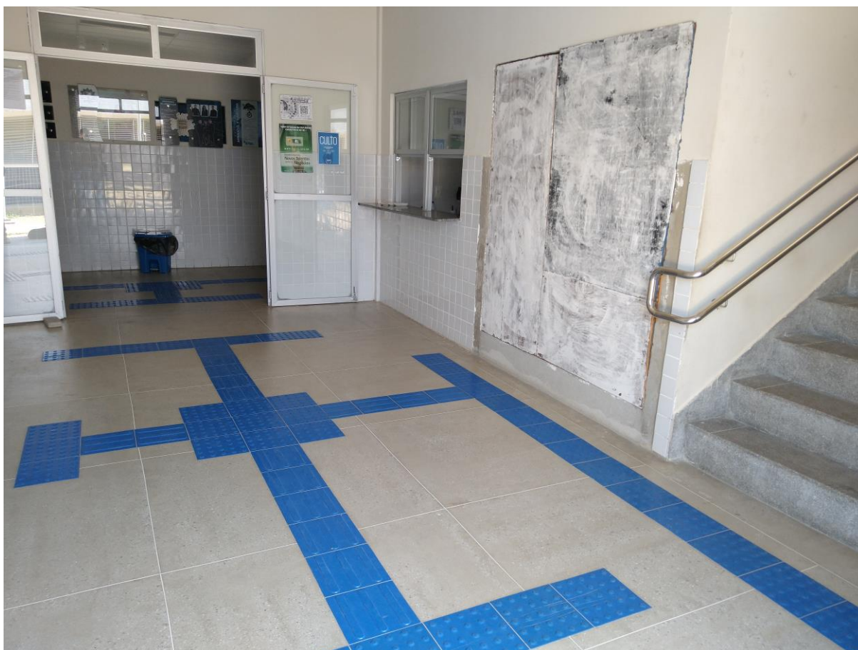
Figura 17: Fosso para instalação do patamar de elevação do prédio de Salas de Aula II.
