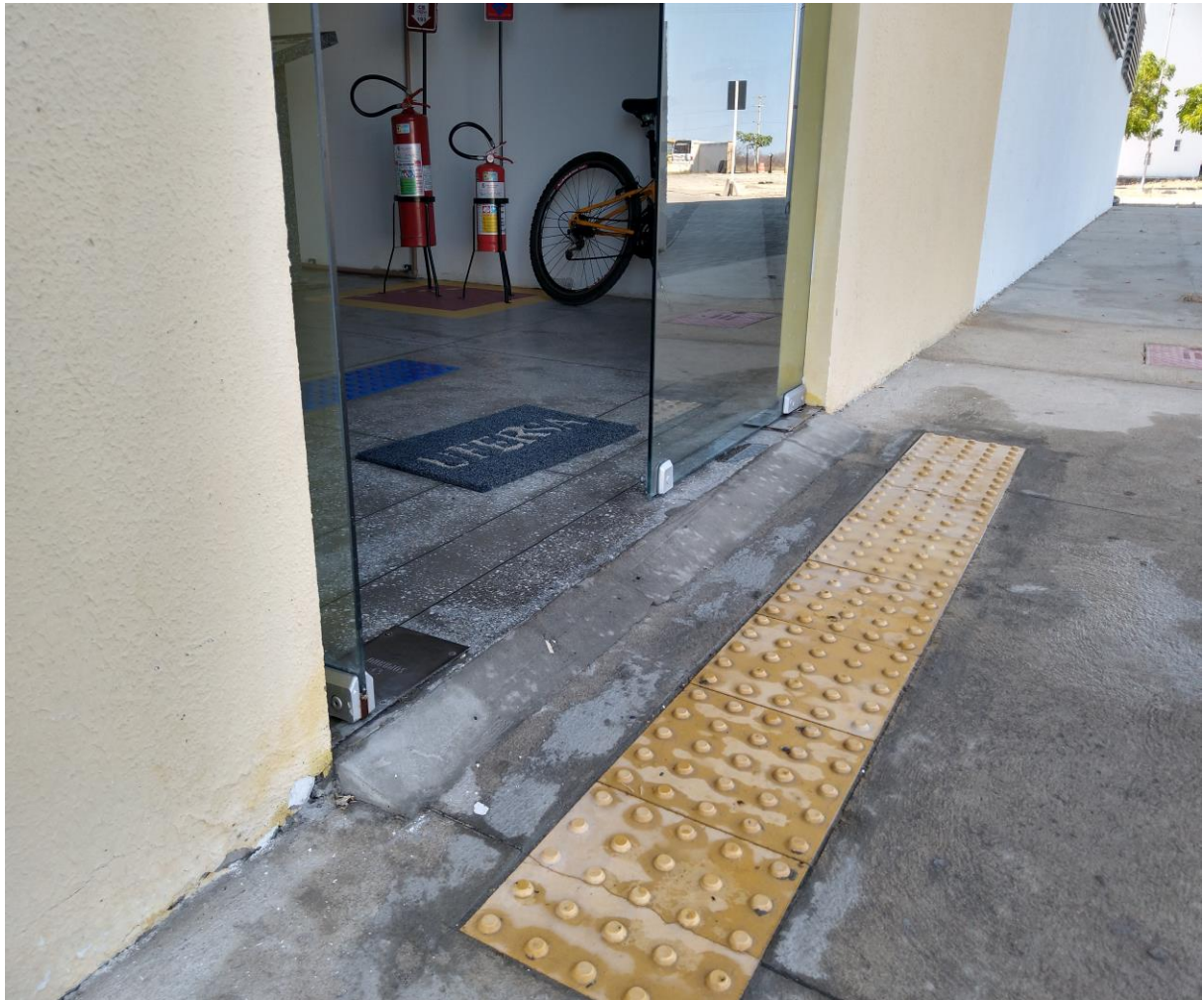
Figura 22: Rampa de acesso à Biblioteca.
