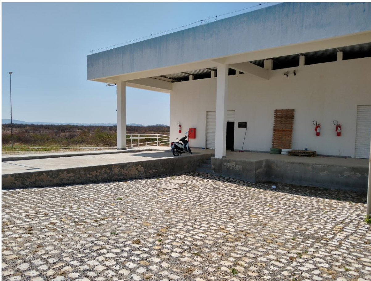
Figura 38: Prédio de Almoxarifado e Patrimônio.
