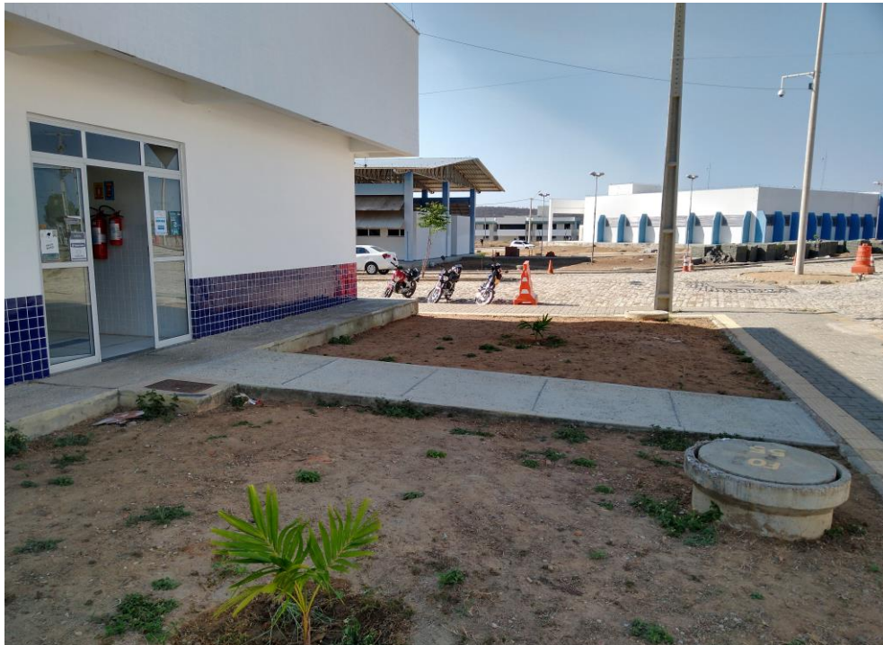
Figura 30: Saída de emergência sem deslocamento - Prédio de Salas de Professores I.
