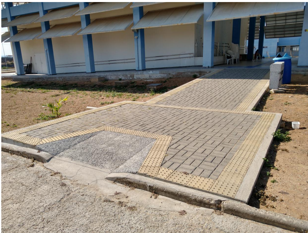
Figura 24: Rebaixamento de calçada e rampa na entrada principal do Centro de Convivência.
