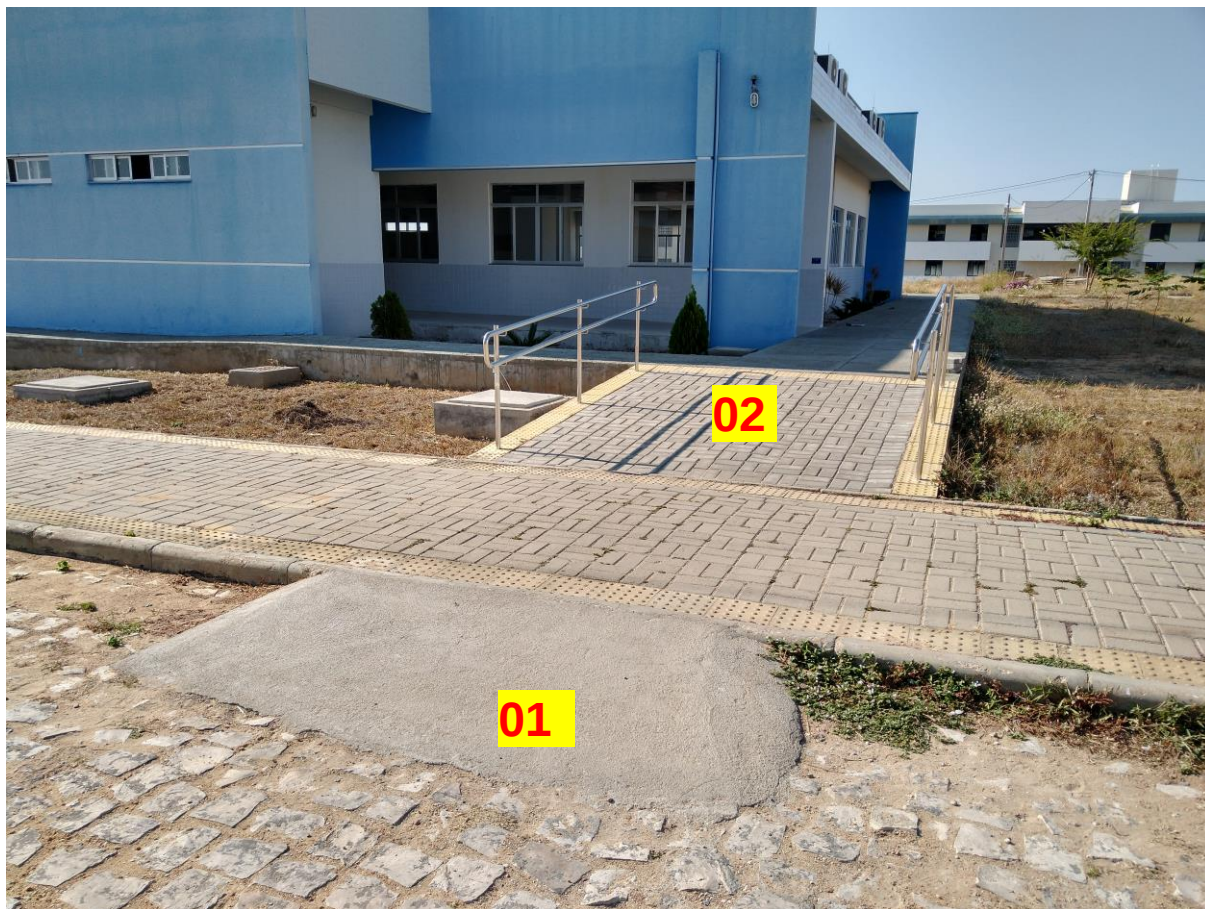
Figura 37: Rampas do prédio de Restaurante Universitário.
