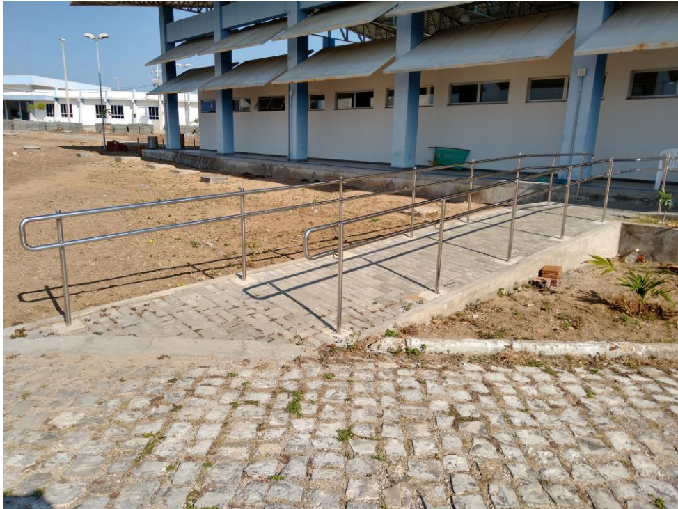
Figura 25: Primeira rampa do acesso com deslocamento à 90° - Prédio de Centro de Convivência.
