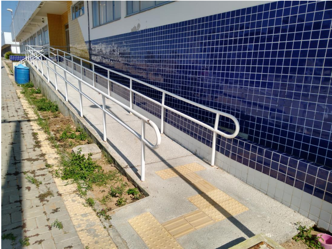
Figura 28: Rampa à esquerda com deslocamento a 90° - Prédio de Salas de Professores I.
