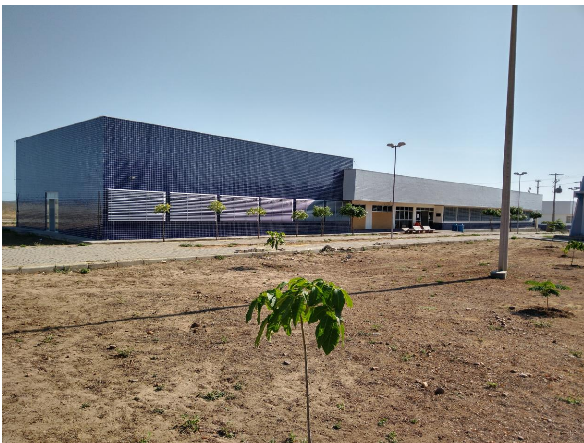
Figura 11: Prédio de Salas de Aula I.
