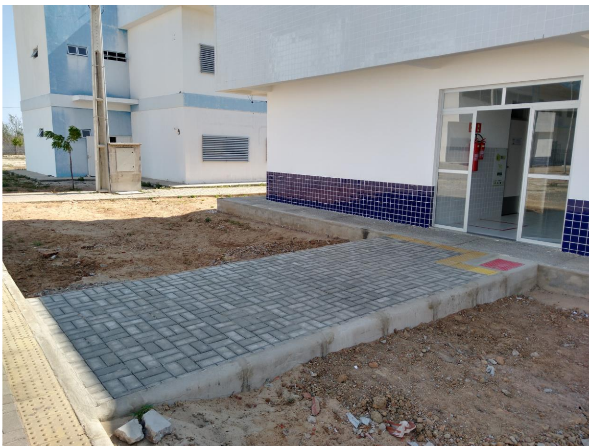
Figura 33: Saída de emergência sem deslocamento - Prédio de Salas de Professores I.
