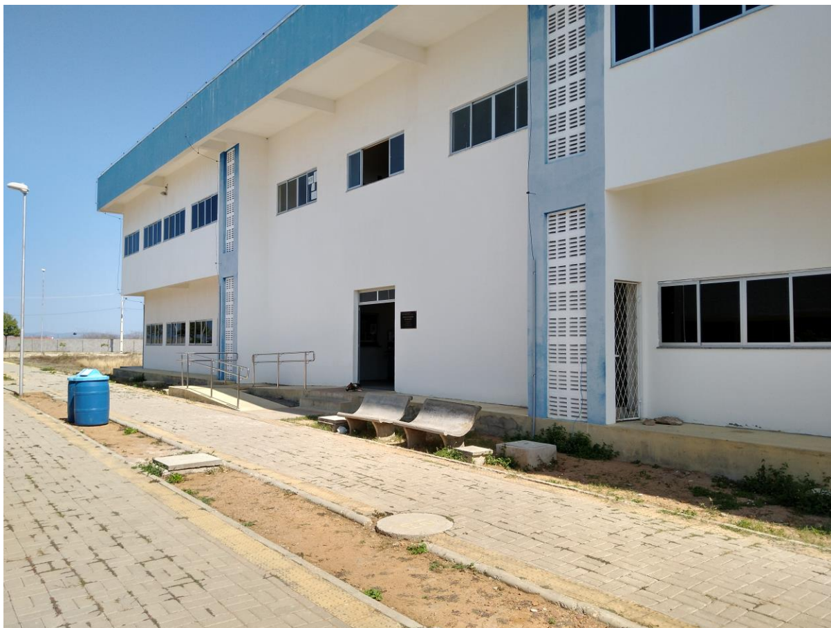
Figura 14: Prédio de Salas de Aula II.
