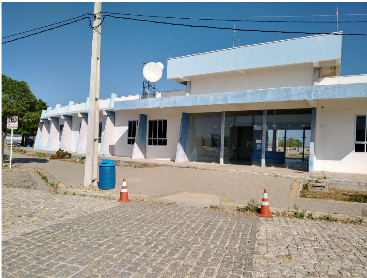
Figura 8: Prédio do Setor Administrativo.
