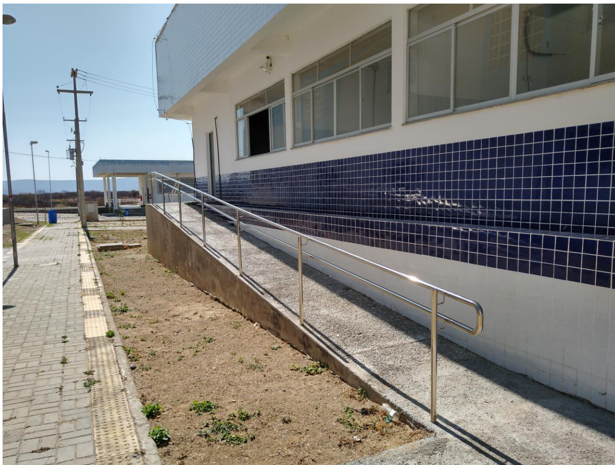
Figura 32: Rampa à esquerda com deslocamento a 90° - Prédio de Salas de Professores II.
