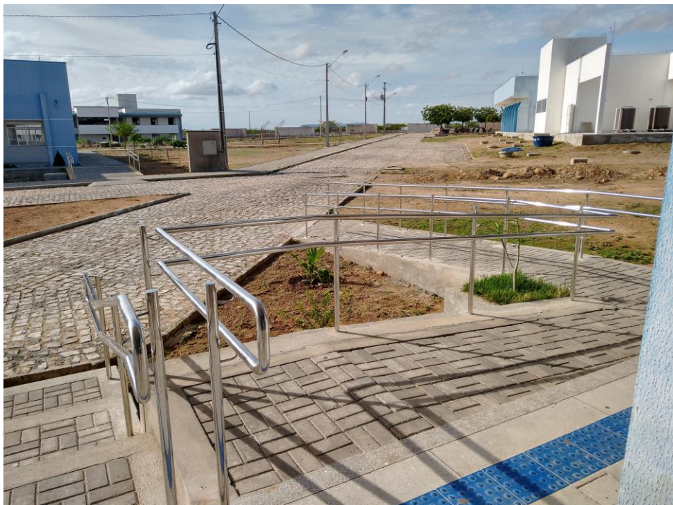
Figura 26: Segunda rampa do acesso com deslocamento à 90° - Prédio de Centro de Convivência.
