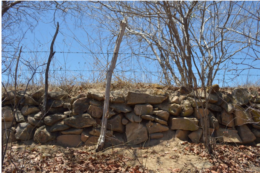
Foto 23: Cerca do Sítio Cazumbá: detalhe da cerca como barreira de contenção
