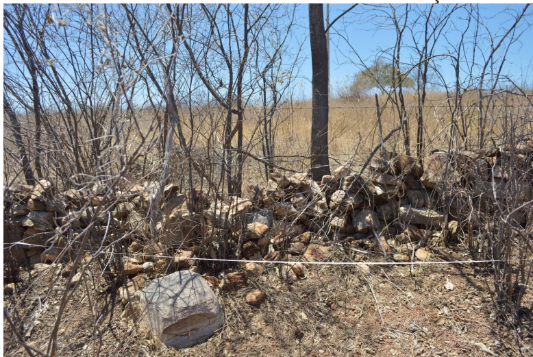
Foto 24: Cerca do Sítio Cazumbá: detalhe da fundação e das fiadas
