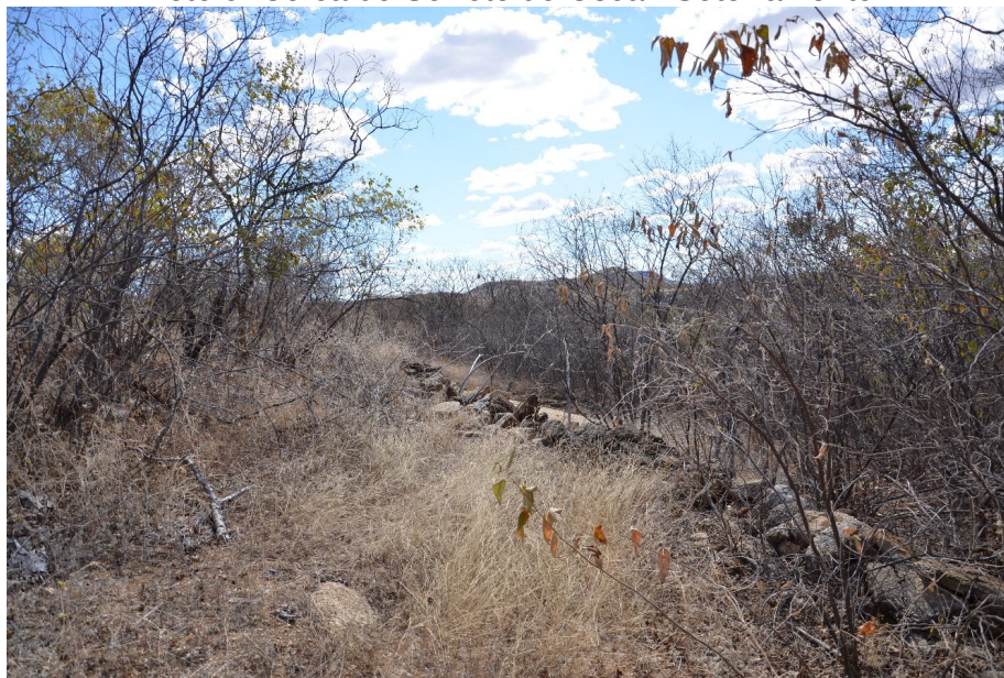
Foto 9: Cerca do Serrote do Oscar: Soterramento
