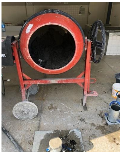
Figura 8 Preparo do concreto na betoneira
