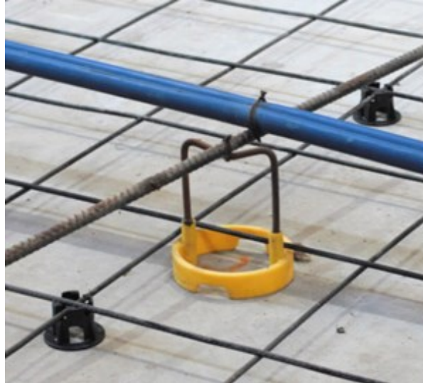
Figura 12 – Espaçador utilizado para afastar as cordoalhas da fôrma.
