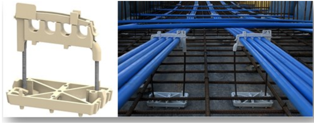
Figura 8 – Espaçador industrializado do tipo cadeirinha para cordoalhas engraxadas.
