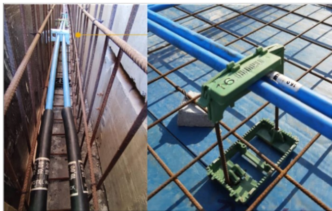
Figura 13 – Espaçador utilizado para separar as armaduras e posicionar as cordoalhas.
