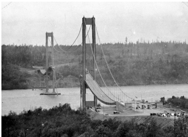
Figura 8- Visualização da ponte Tacoma Narrows.
