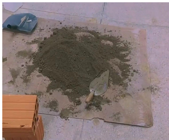
Figura 4: Mistura homogênea (FONTE: Autoria própria)
