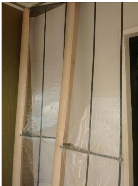
Figura 28 –Pás devidamente finalizadas.
