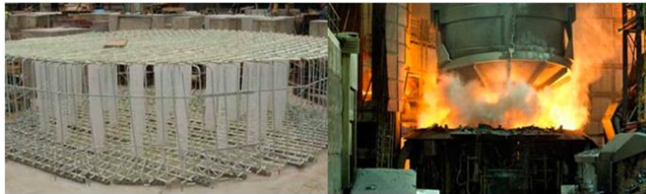
Figura 10: Fundação para forno de aço
