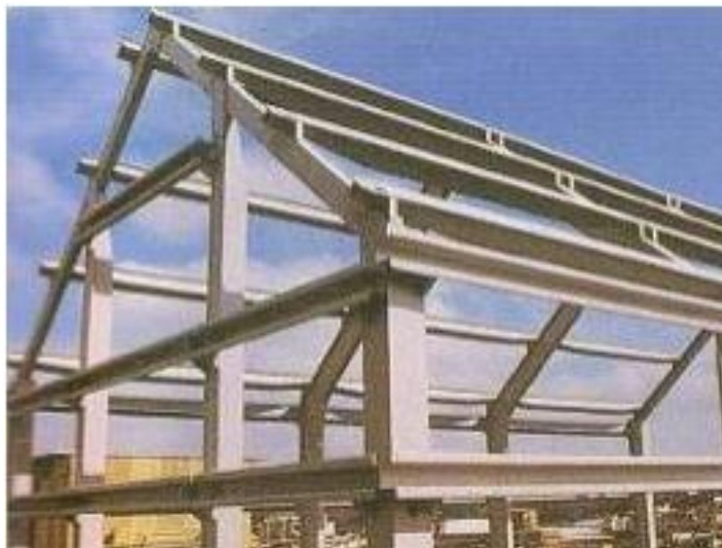
Figura 8: Estrutura pré-moldada construída com GFRP
