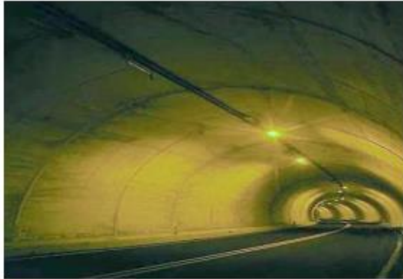
Figura 7: Túnel construído com concreto armado com GFRP
