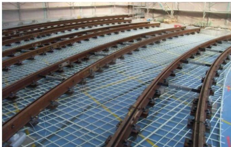
Figura 11: Placa de base para leito ferroviário na Suíça
