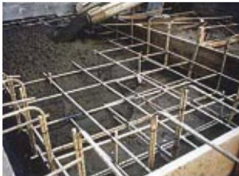
Figura 15: Estrutura de fundação utilizando GFRP
