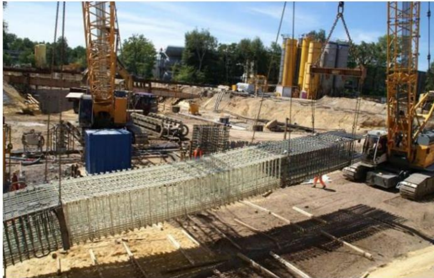
Figura 12: Construção subterrânea na Alemanha
