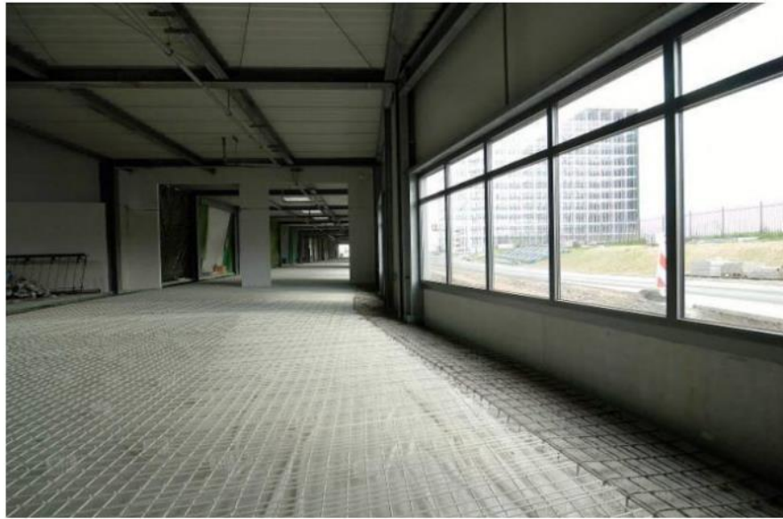
Figura 9: Reforço com GFRP para evitar rachaduras
