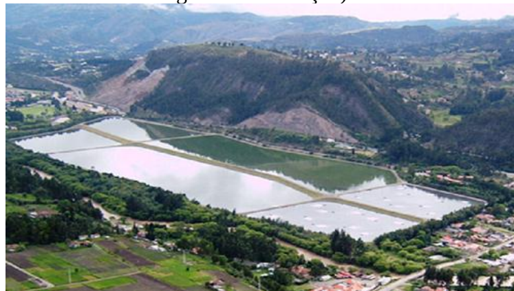
Figura 10: ETE Ucubamba, Cuenca, Equador (2 lagoas aeradas, duas lagoas facultativas e duas lagoas de maturação)
