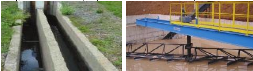
Figura 6: Caixa de areia, limpeza manual e desarenador, limpeza mecanizada
