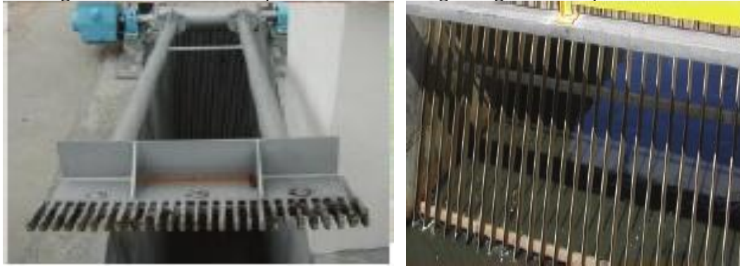
Figura 5: Grade fina, limpeza mecanizada e grade grossa, limpeza manual
