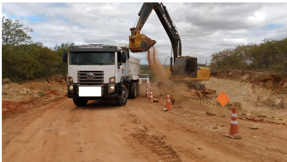
Figura 8: Execução de Nivelamento de Terreno
