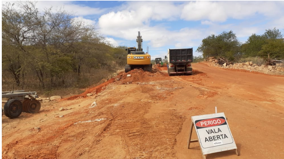
Figura 12: Sinalização Vala Aberta
