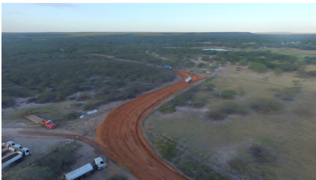
Figura 1: Terraplenagem em Fase de Execução.
