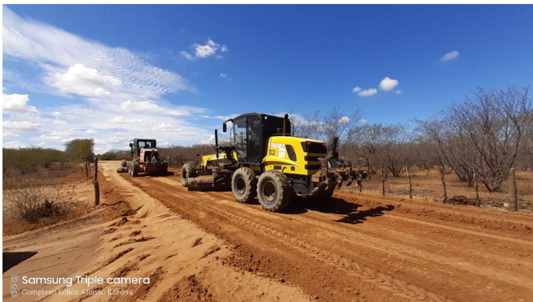
Figura 2: Construção de Via de Acesso.
