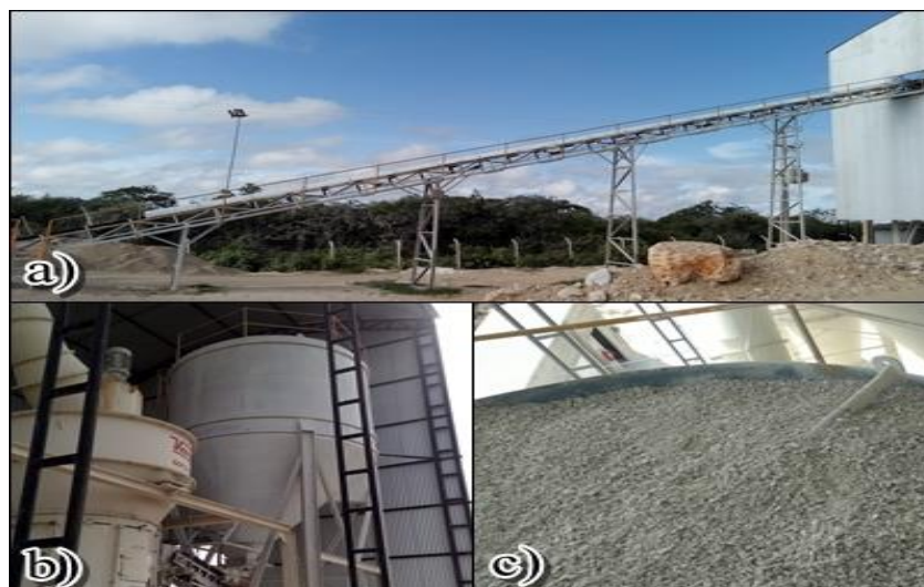
Figura 6. a) Esteira de transporte da pedra britada; b) Vista frontal do silo de armazenamento; c) Vista superior do silo de armazenamento cheio. (Fonte: Mineração Ouro Branco LTDA, 2012)
