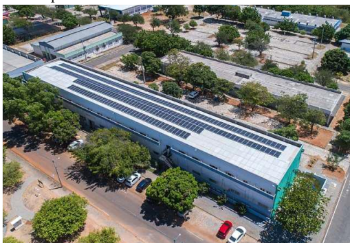
Fig. 14. Vista superior da Usina Solar Mossoró X.
