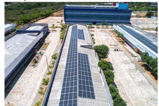
Fig. 12. Vista superior da Usina Solar Mossoró VIII.
