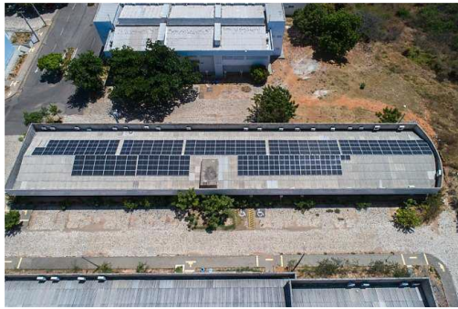
Fig. 13. Vista superior da Usina Solar Mossoró IX.
