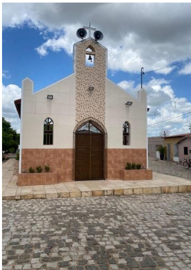
Figura 7 - Atual fachada da capela do bairro Alto São Geraldo.
