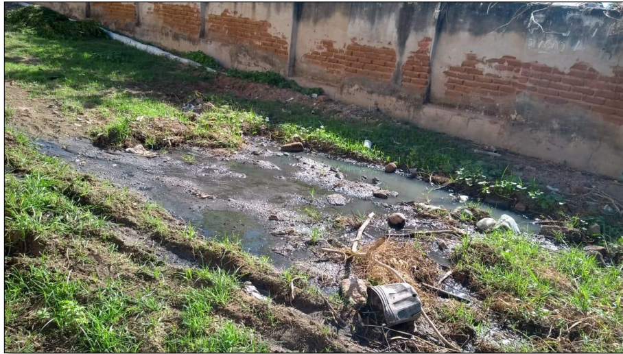
Figura 23 - Esgoto na Rua Bevenuto Jácome. Sua disposição é no Rio Upanema
