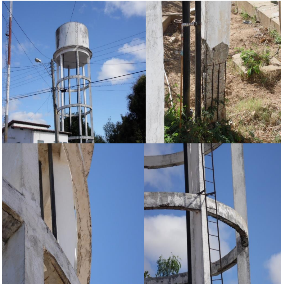
Figura 14 - Caixa de água da CAERN em Campo Grande/RN, desativada
