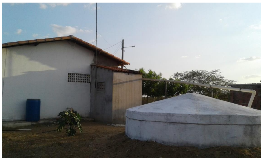
Figura 15 - Cisterna de placa ligada a uma residência no Sítio Oiteiros, Campo Grande/RN
