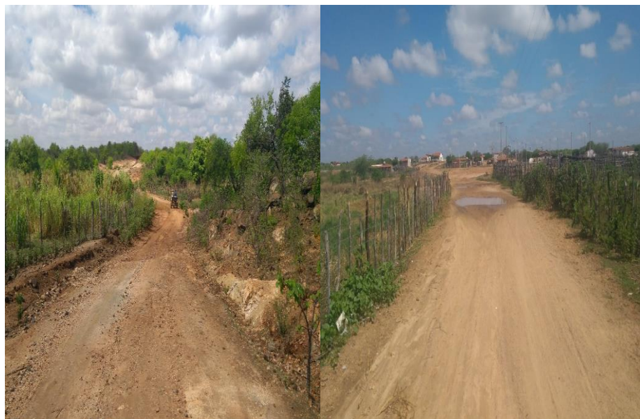
Figura 43 - Pontos de alagamento nas comunidades Caina e Bom Jesus
