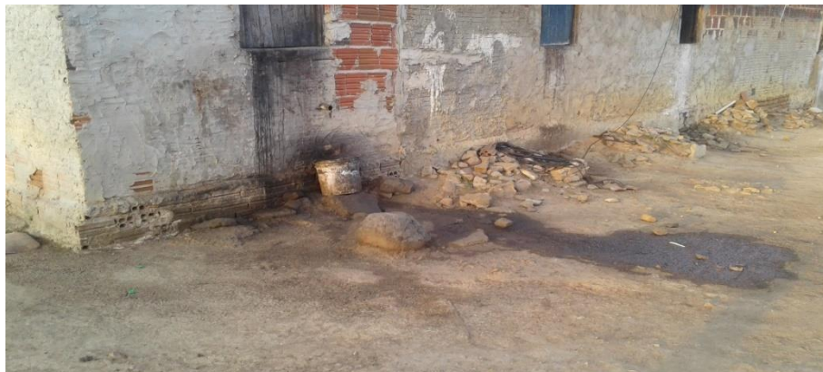
Figura 28 - Esgoto a céu-aberto na zona rural de Campo Grande/RN
