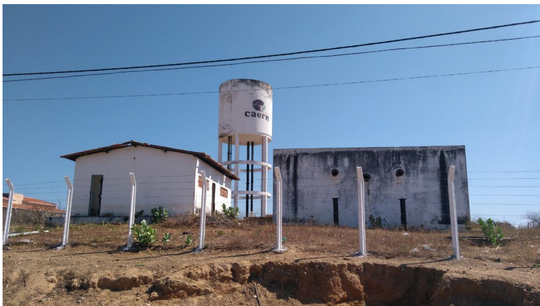
Figura 11 - Caixa de abastecimento de Campo Grande/RN
