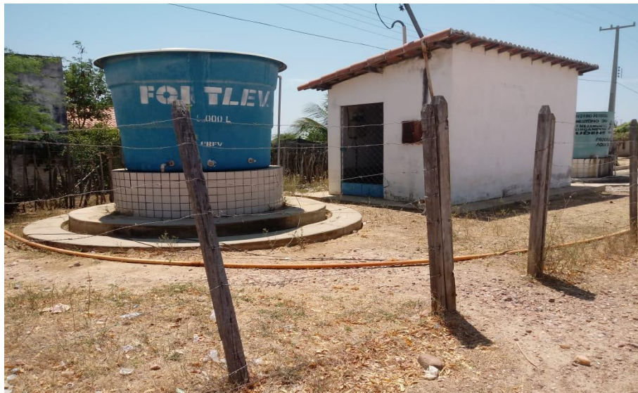
Figura 17 - Poço da comunidade Bom Jesus, Campo Grande/RN
