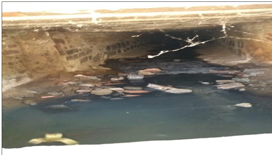
Figura 24 - Canal de esgoto na Rua Cel. Antônio Melo
