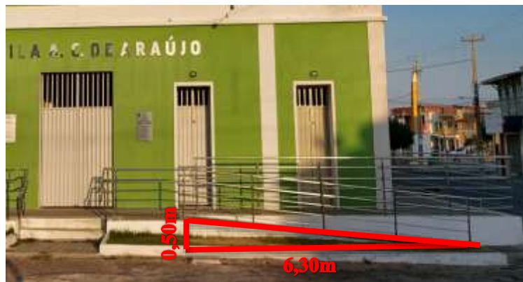
Figura 09: Rampa de acesso principal ao Mercado Público (Segmento 2).
