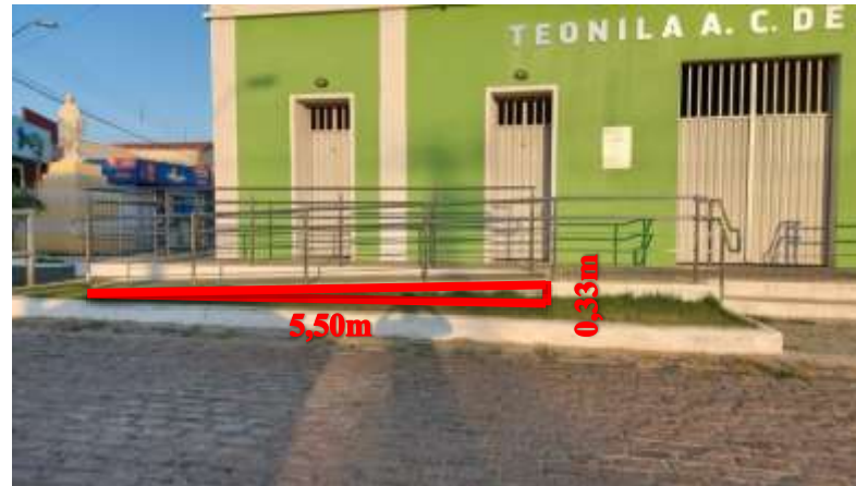
Figura 08: Rampa acesso principal ao Mercado Público (Seguimento 1).
