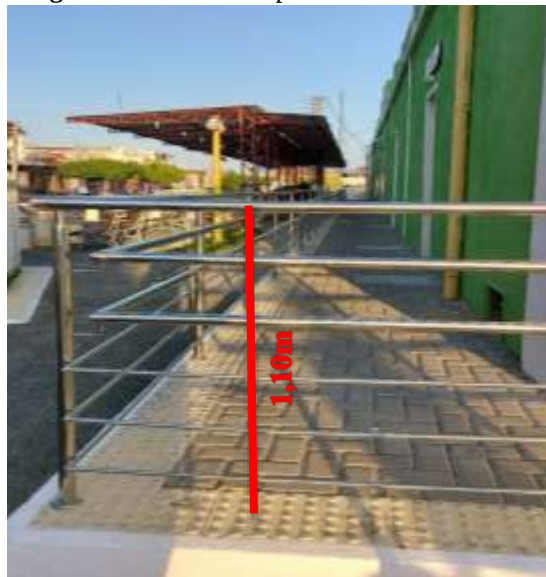
Figura 12: Guarda Corpo no Mercado Público.
