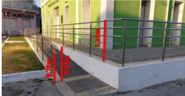
Figura 11: Corrimãos de acesso principal ao Mercado Público (segmento 2).
