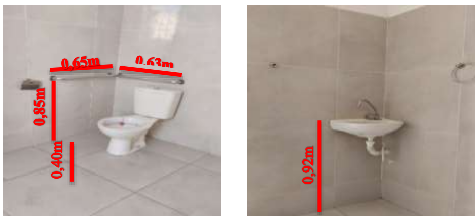
Figura 13: Banheiro com medidas existente das barras de apoio no Mercado Público de Angicos
