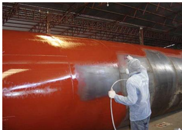
Figura 19: Aplicação de pintura anticorrosiva.
