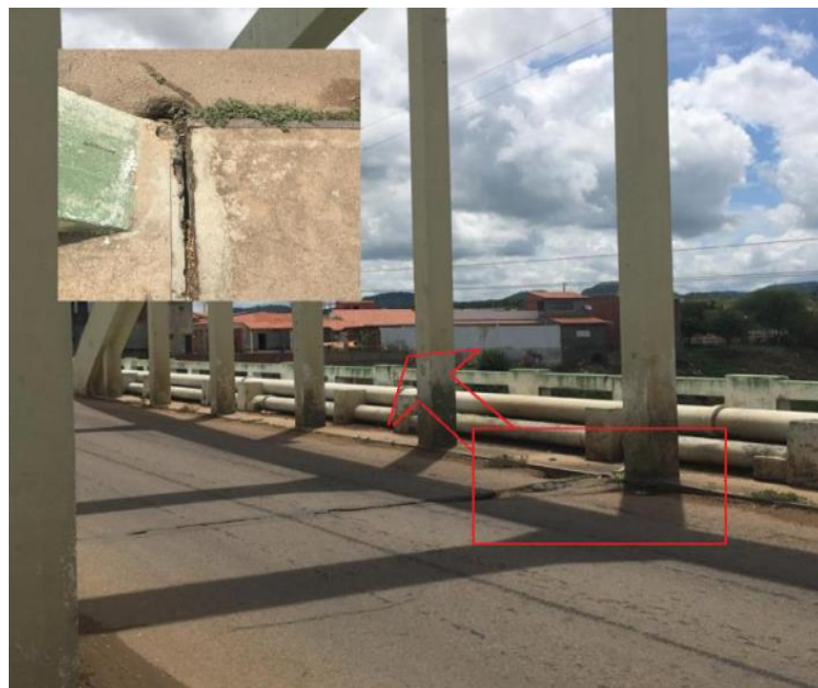
Figura 25- Detalhes da pingadeira
