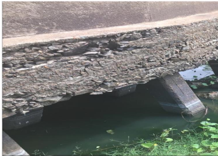
Figura 31- Estacas da infraestrutura
