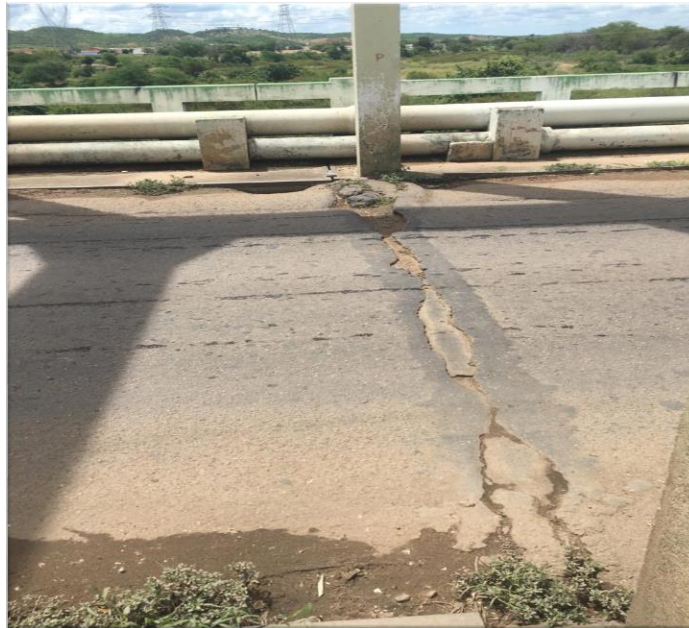
Figura 24- Detalhe das juntas de dilatação
