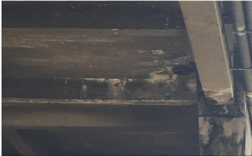
Figura 27- Manifestações patológicas do tipo eflorescência e manchas
