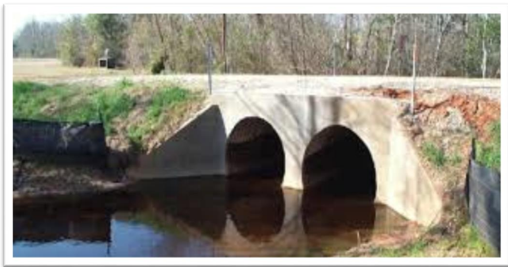
Figura 2 – Ponte tipo Bueiro
