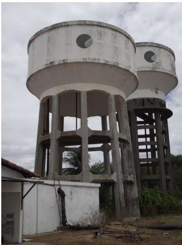
Figura 8 – Reservatórios Elevados (1 e 2) e Reservatório Apoiado
