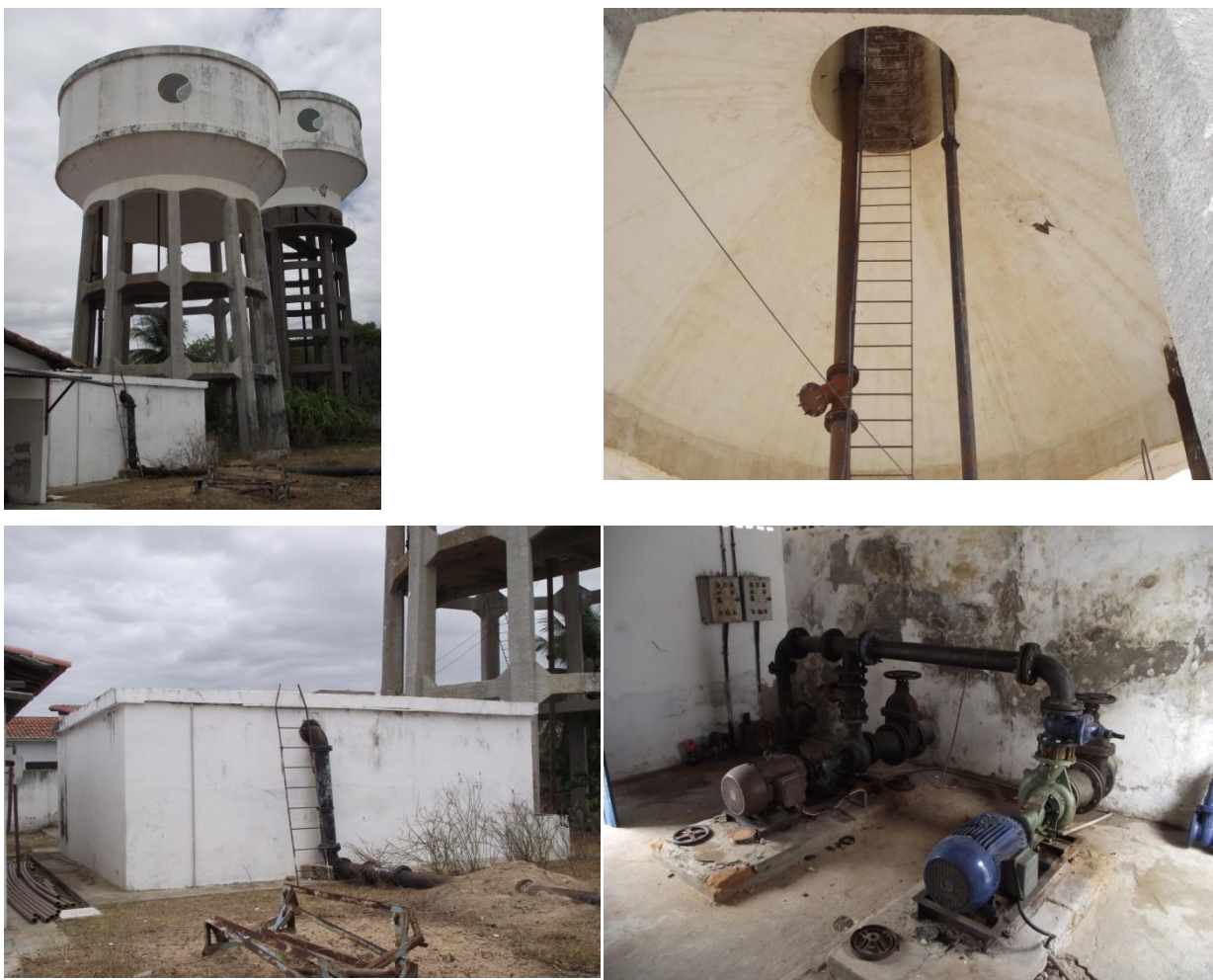
Figura 13 – Vistas do sistema de reservação atual do município de Angicos
