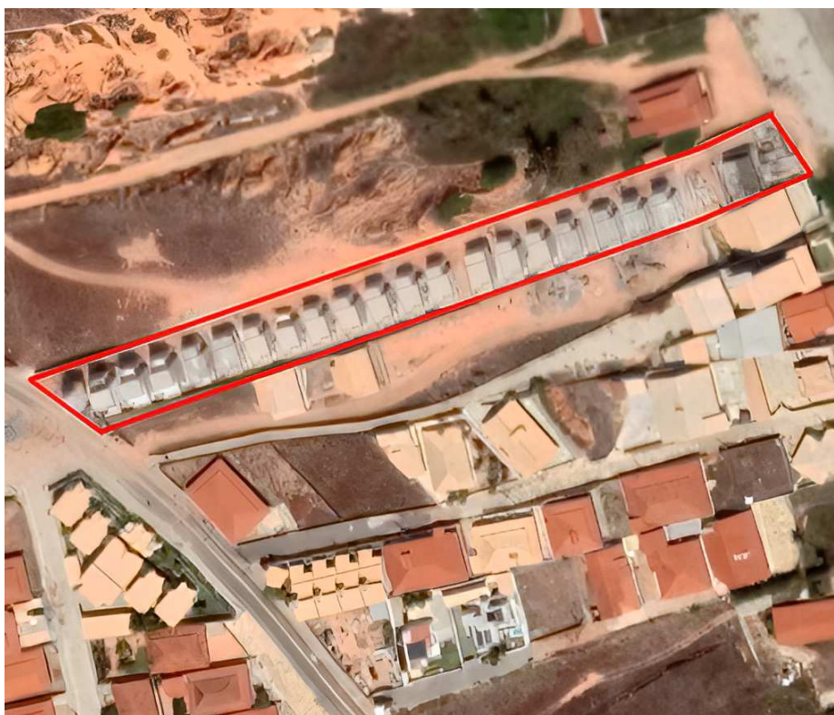
Figura 4: Vista satélite da obra.
