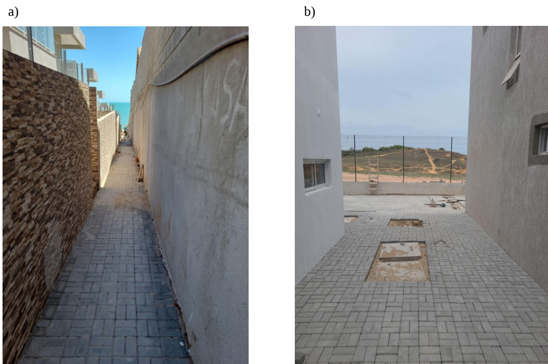
Figura 5: (a) Via de acesso da área comum; (b) Via de acesso entre as unidades, que após concluída será só de uma das unidades.
