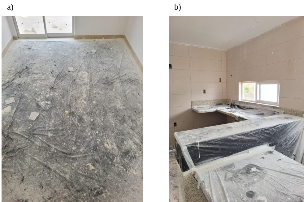
Figura 11: (a) Lona sobre piso porcelanato aplicado (b) Lona sobre bancadas de granito assentadas.
