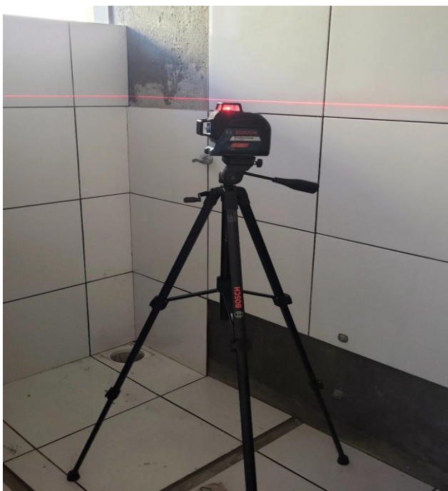
Figura 6: Nível a laser utilizado em marcação de piso, revestimentos e bancadas.
