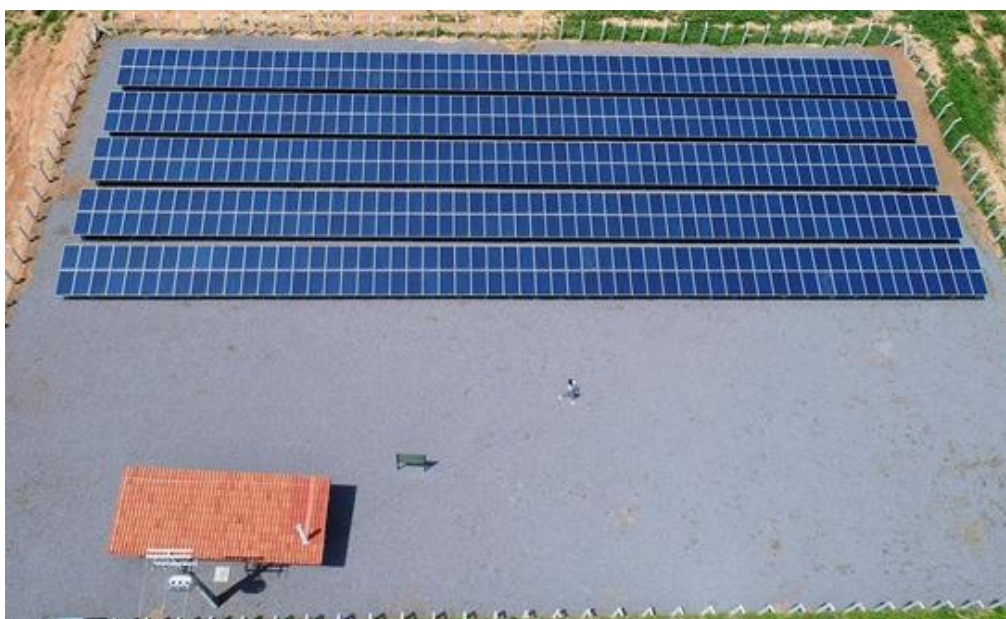
Figura 37: Imagem aérea da usina Mossoró II.
