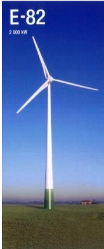
Figura 11: modelo E-82 E2 da Wobben Windpower Enercon. Fonte: Enercon.
