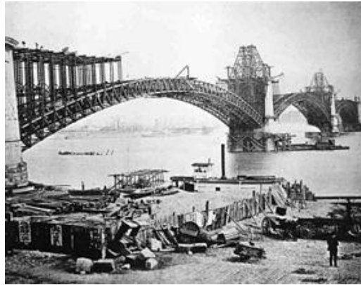
Figura 4 – Construção da ponte sobre o Rio Mississipe (Eads Bridge)
