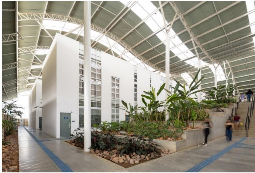
Figura 2 – Imagem interna da cobertura.
