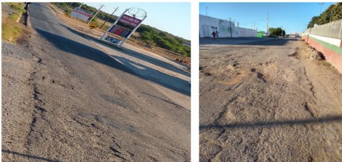
Figura 7: Junção da reestruturação da RN-118 com o restante do trecho urbano
