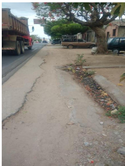
Figura 12 – Esgoto a céu aberto em uma rua principal do Bairro Princesinha do Oeste
