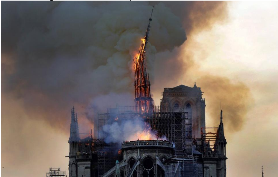
Figura 5 - Momento em que a torre da catedral desabou
