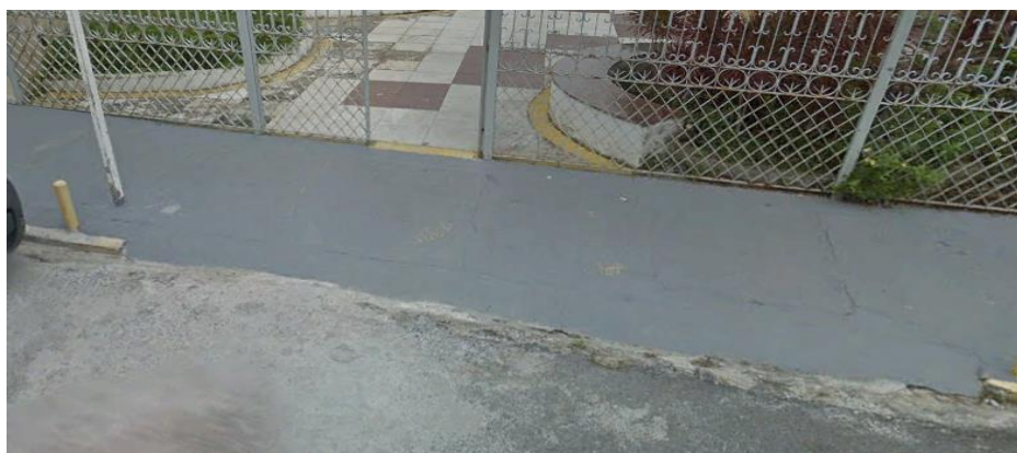
Figura 13: Rebaixamento da calçada na entrada da praça do IHGRN
