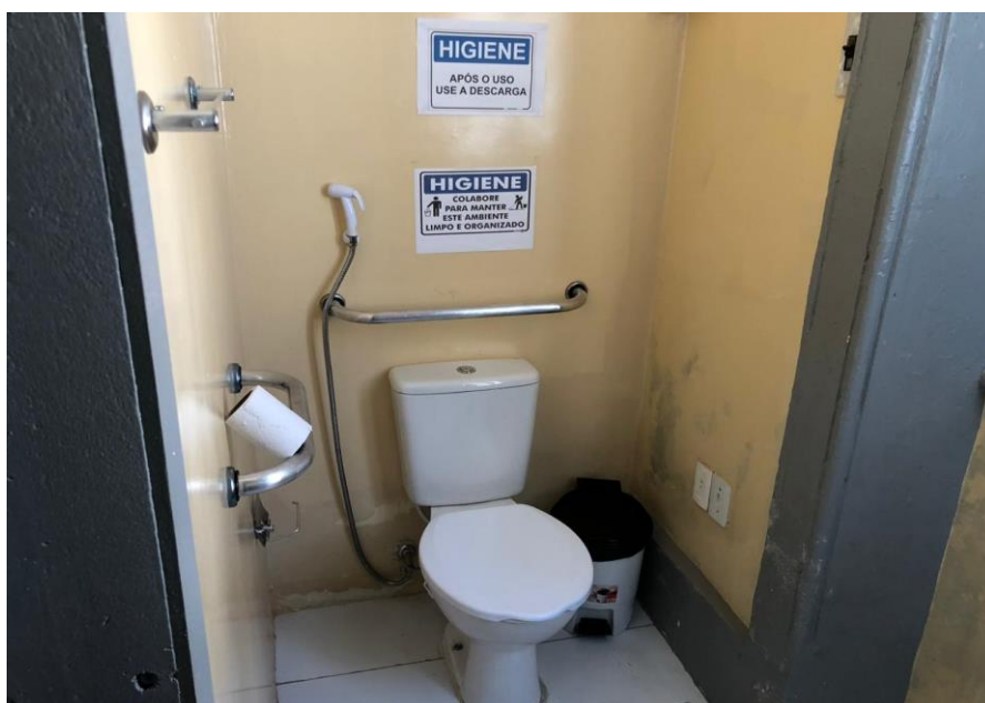
Figura 20: Barras de apoio no interior do banheiro feminino
