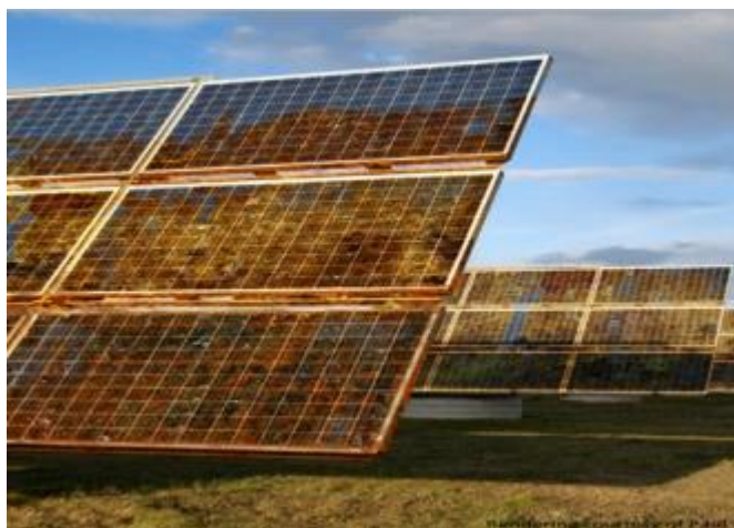
Figura 07 - Corrosão de painéis solares
