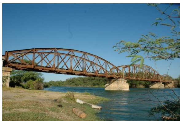
Figura 2. Ponte ferroviária de Mossoró (Lindomarcos Faustino/2005).
