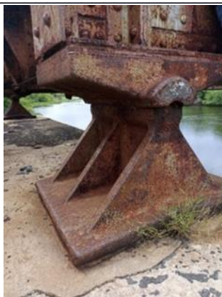
Figura 6. Apoio duplo tipo pino. (Autoria própria)
