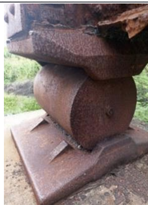
Figura 7. Apoio simples tipo rolete. (Autoria própria)
