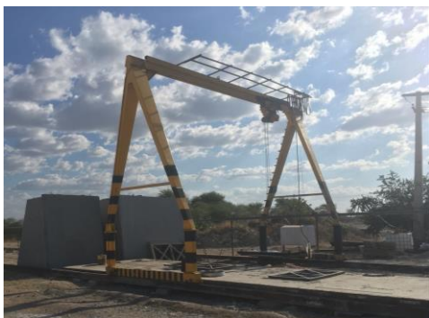
Figura 8. Ponte rolante que fará a elevação da peça pré-moldada pronta. (Autoria própria).
