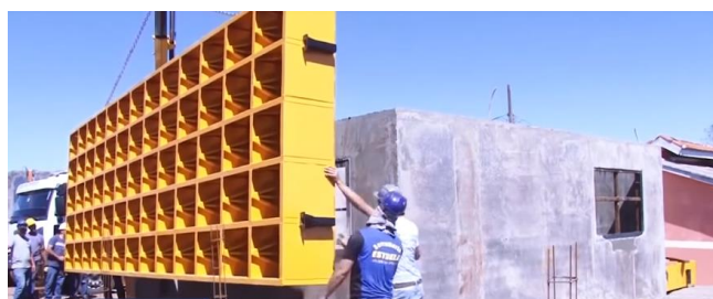
Figura 17. Retirada das fôrmas. (Elaine Cunha, acessado dia 26 de Agosto de 2018, https://www.youtube.com/watch?v=1J2FQ3jH8J8 )
