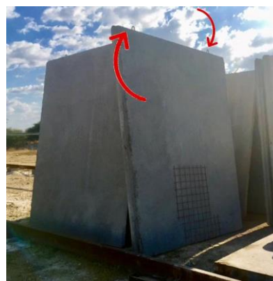
Figura 9. Paredes pré-moldadas em processo de cura com ganchos para facilitar o içamento. (Autoria própria)
