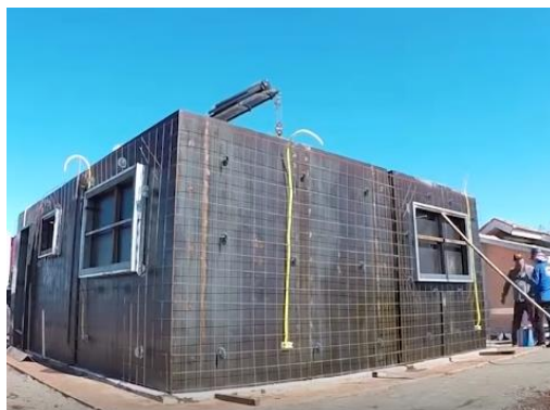
Figura 14. Fôrma interna com tela metálica, eletrodutos e esquadrias posicionados. (Elaine Cunha, acessado dia 26 de Agosto de 2018, https://www.youtube.com/watch?v=1J2FQ3jH8J8 )
