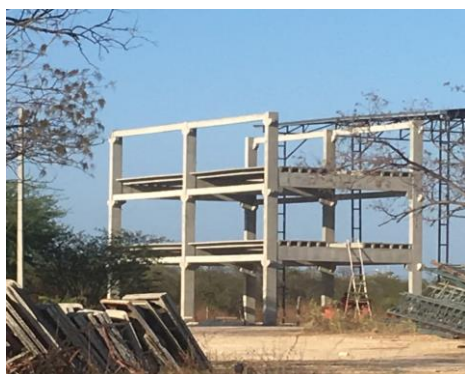
Figura 1. Estrutura pré-moldada em esqueleto. (Autoria própria)
