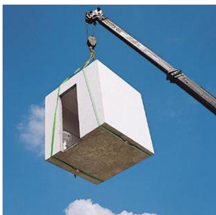
Figura 4. Célula de banheiro pré-fabricada sendo içada pra posicionamento na obra. (Serra, S.M.B.; Ferreira, M.de A.; Pigozzo, B. N, 2005)
