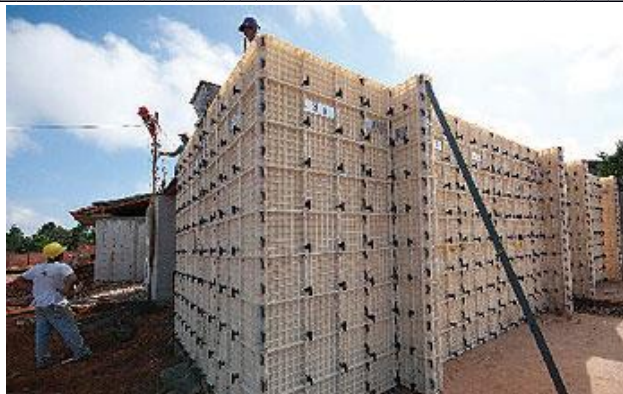
Figura 13. Fôrma plástica para moldagem das paredes de concreto moldadas in loco . (SILVA, F. B. d. , Revista Técnica, Edição 165 - Dezembro/2012, disponível em: < http://techne17.pini.com.br/engenharia-civil/165/sistema-de-formas-plasticas-para-paredes-de-concreto-287803-1.aspx >).
