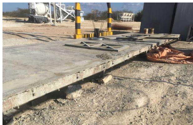
Figura 7. placa metálica inferior da fôrma, com ganchos laterais de travamento para posterior montagem dos outros componentes da fôrma. (Autoria própria).
