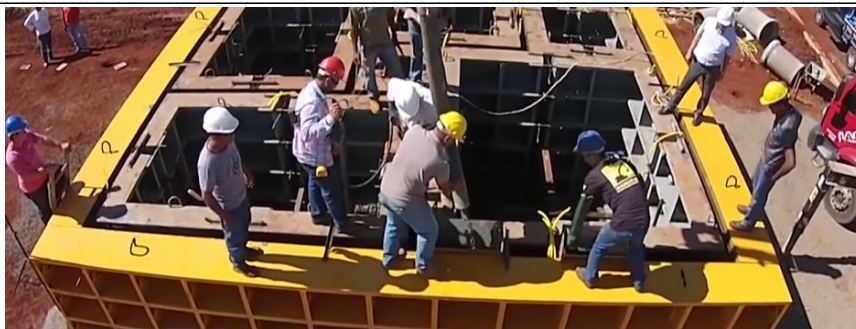
Figura 16. Colocação do concreto na fôrma por bombeamento. (Elaine Cunha, acessado dia 26 de Agosto de 2018, https://www.youtube.com/watch?v=1J2FQ3jH8J8 )
