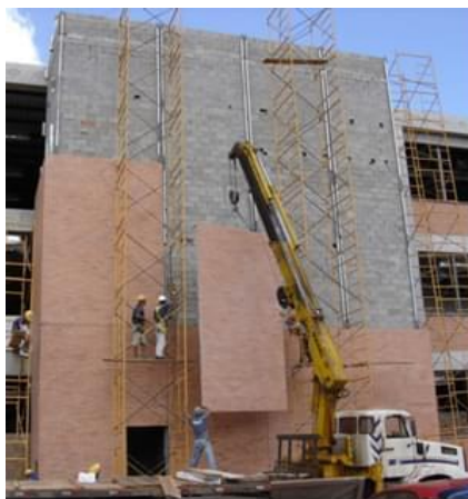
Figura 3. Colocação de fachada pré-fabricada de concreto na edificação. (Redação AECweb / e-Constumarket, acessado dia 26 de Agosto 2018. Disponível em: < https://www.aecweb.com.br/cont/m/rev/fachadas-prefabricadas-agilizam-a-obra_7040_10 > )
