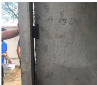
Figura 10. Junção de paredes pré-moldadas por soldas, antes do preenchimento de junção. (Autoria própria).
