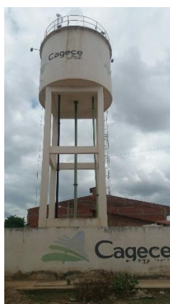
Figura 1. Reservatório de água da CAGECE no distrito de Flores/CE. (Autoria Própria, 2020).
