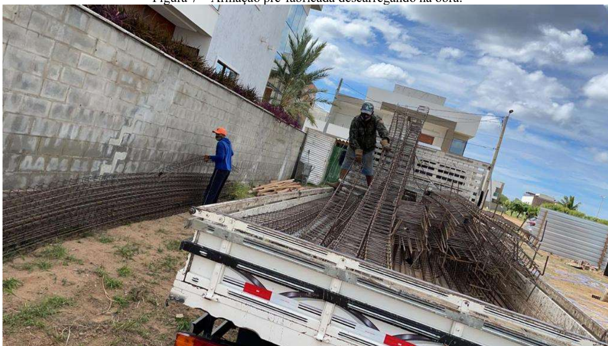
Figura 7 – Armação pré-fabricada descarregando na obra.
