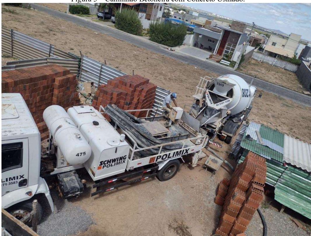
Figura 5 – Caminhão Betoneira com Concreto Usinado.
