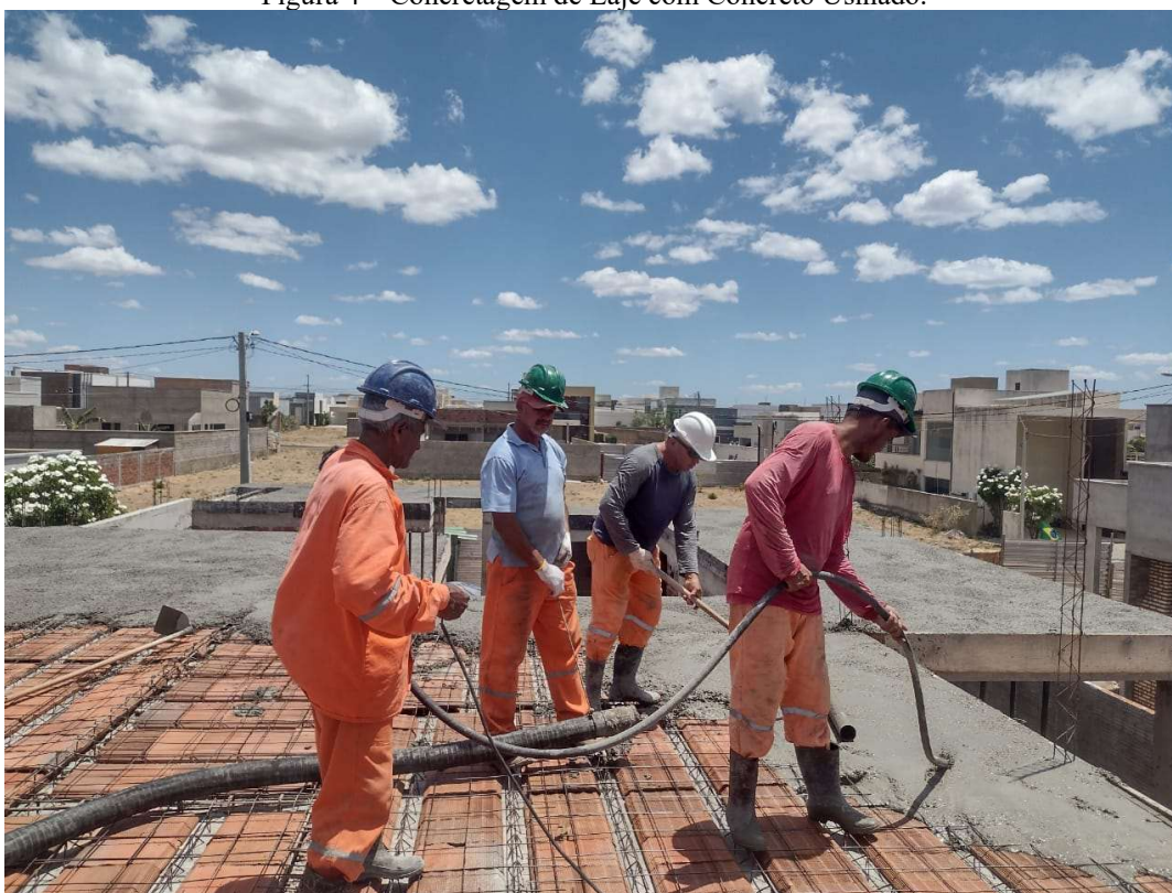
Figura 4 – Concretagem de Laje com Concreto Usinado.
