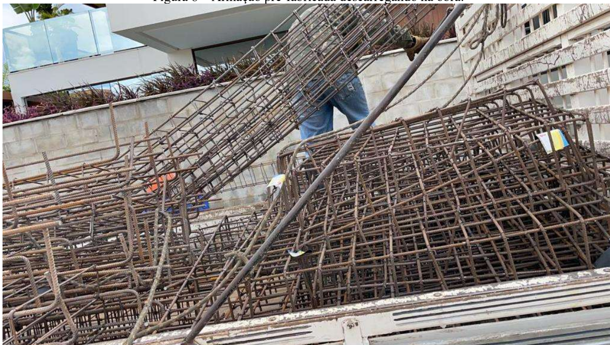
Figura 8 – Armação pré-fabricada descarregando na obra.
