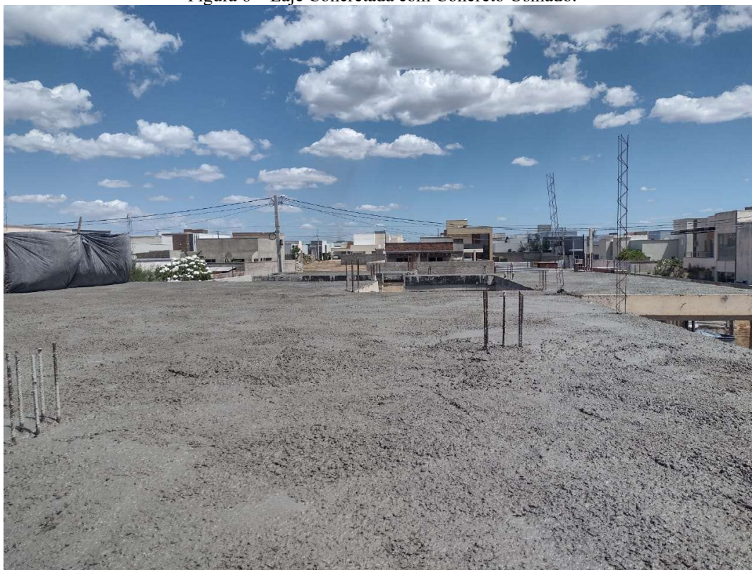
Figura 6 – Laje Concretada com Concreto Usinado.
