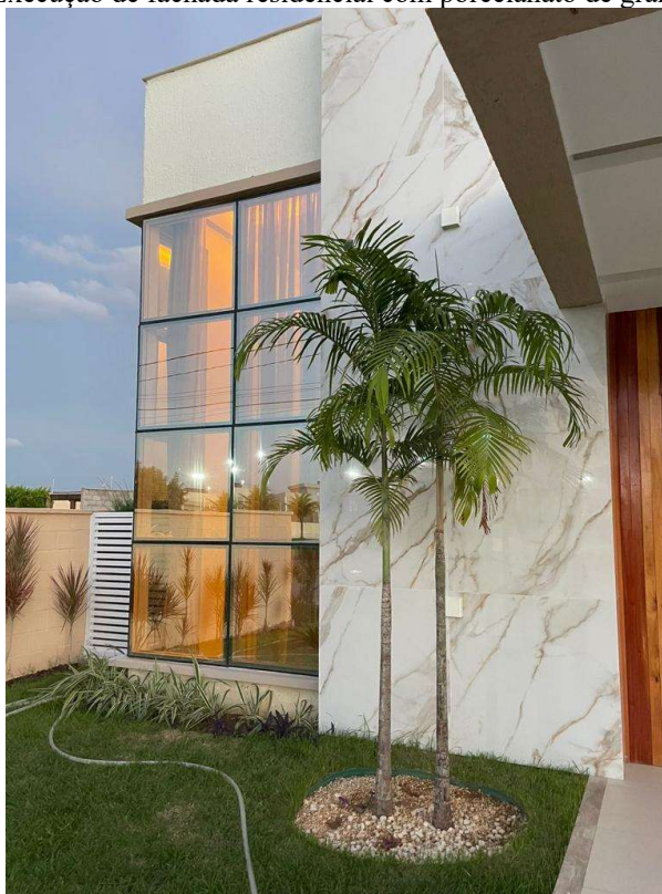
Figura 12 – Execução de fachada residencial com porcelanato de grandes formatos.
