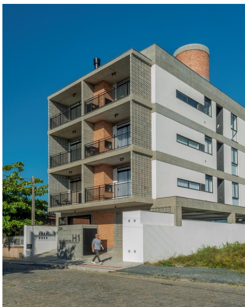
Figura 18: Edifício H1 localizado na cidade de Balneário Piçarras/SC.
