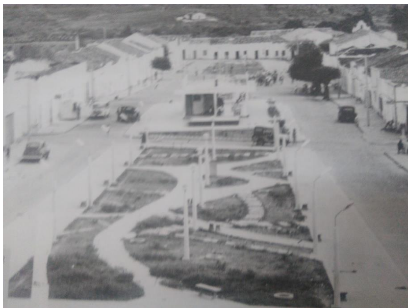
Figura 25: Vista aérea da Avenida Dr. Gregorio de Paiva, ao centro a Praça Maria Cavalcante e o Pavilhão Municipal. Destaca-se ao fundo do lado direito a Igreja Sagrado Coração de Jesus.
